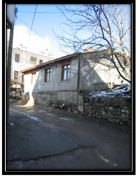
Resim 3.11 Sülüklü Sokak görünüm 2
