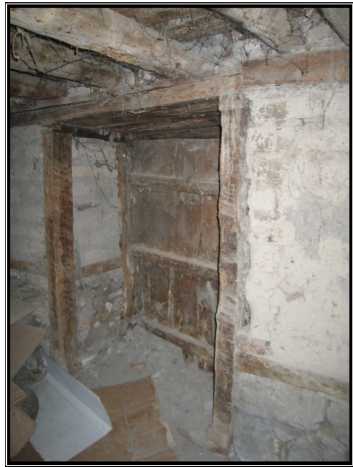
Resim 4.57. B02 Depo giriş kapısı iç
