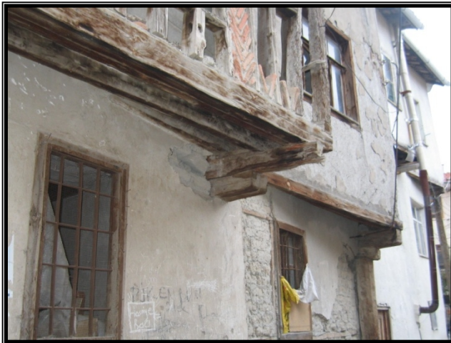
Resim 4.68 Ön cephe sağ konsol
