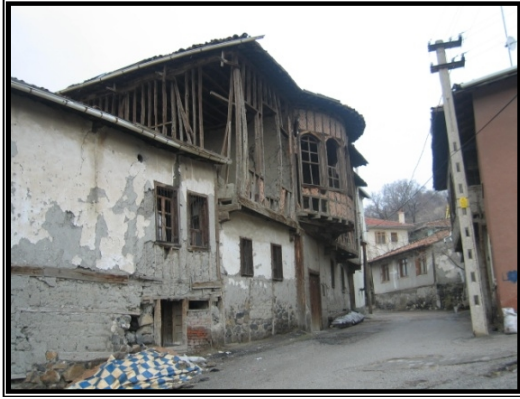
Resim 4.73 Sol yan cephe 1
