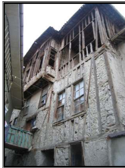
Resim 4.4 Arka cephe girişi
