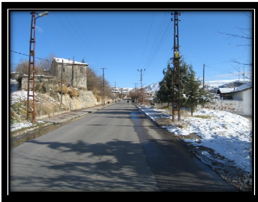
Resim 3.20 Sülüklü Sokak görünüm 11
