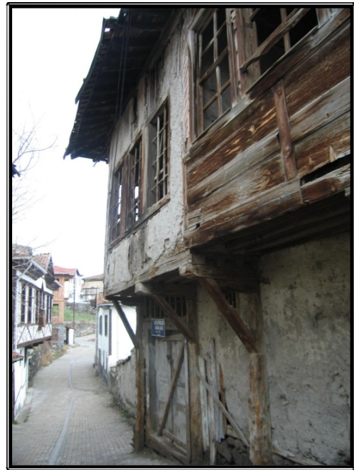
Resim 2.6 Sokak kaplaması (taş)
