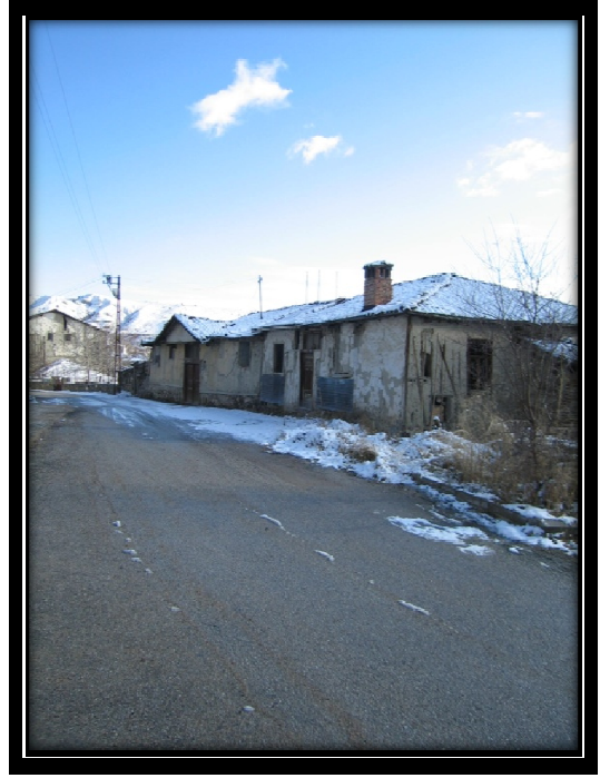
Resim 3.23 Sülüklü Sokak görünüm 14
