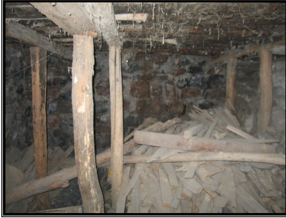
Resim 4.52 Ahşap kolonlar ve hatıllar
