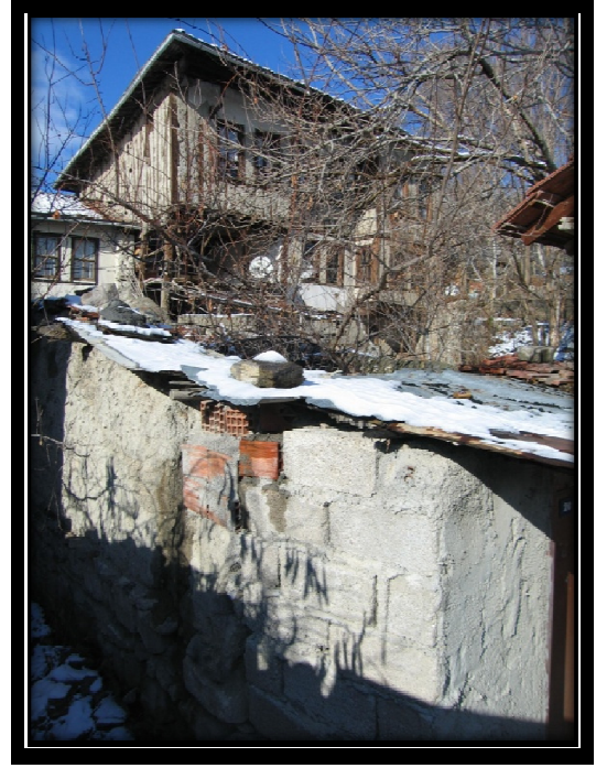
Resim 3.27 Sülüklü Sokak görünüm 18
