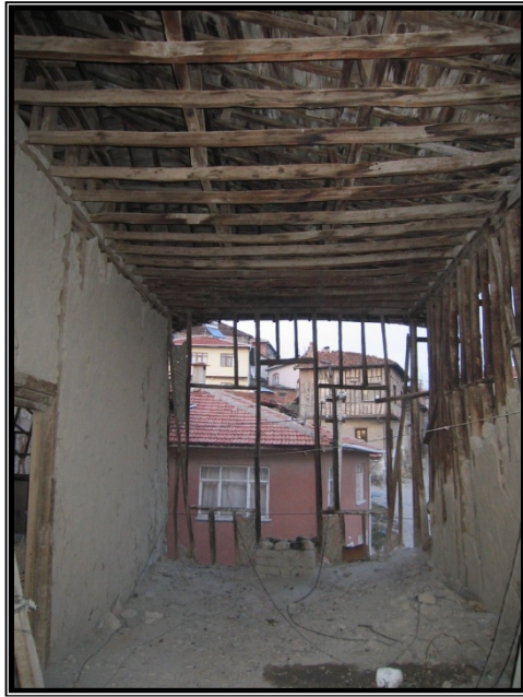
Resim 1.136 Pencere kayıp malzeme Resim 4.137 Ahşap tavan kayıp malzeme
