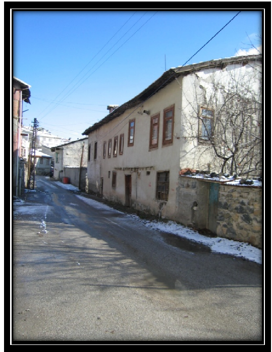
Resim 3.25 Sülüklü Sokak görünüm 16
