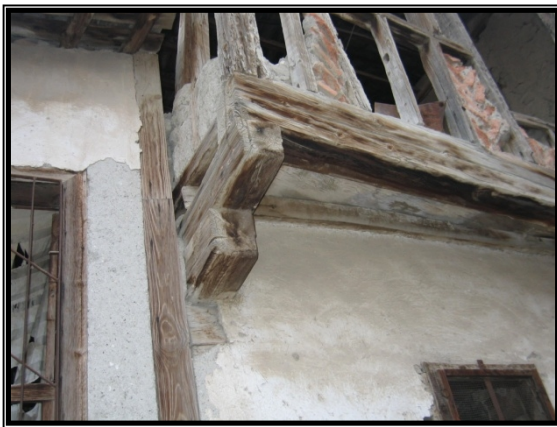
Resim 4.83 Ön cephe ahşap konsol
