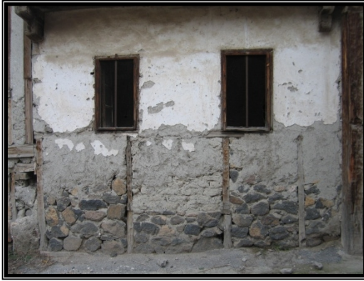
Resim 4.64. Ön cephe zemin kat sol
