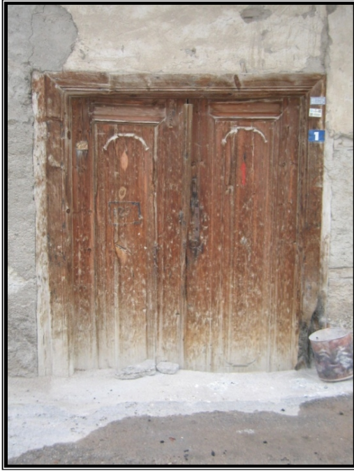
Resim 4.104 DK 1 kapı görünüş dış
