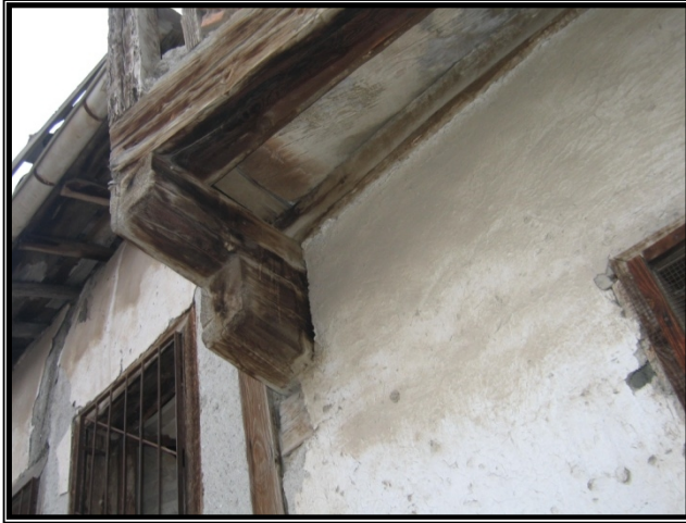
Resim 4.67 Ön cephe sol konsol
