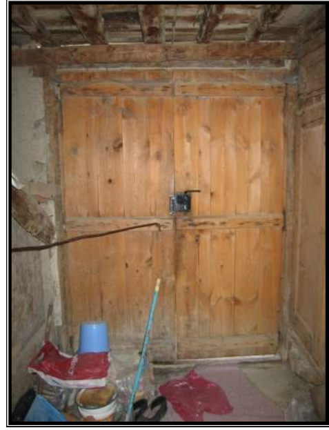
Resim 4.108 DK 2 kapısı görünüş iç
