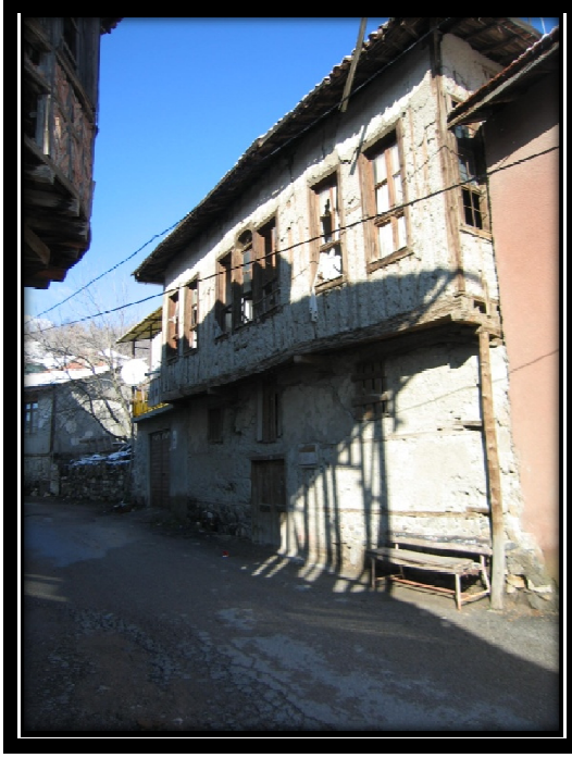
Resim 3.10 Sülüklü Sokak görünüm 1
