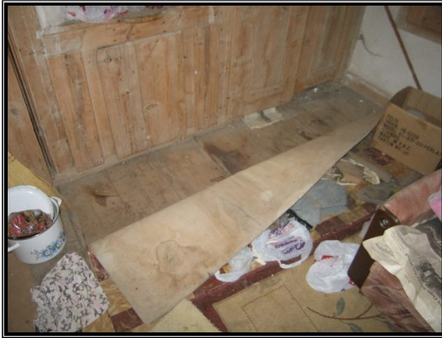
Resim 4.15 Z02 Odası zemini döşeme tahtası
