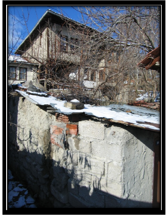
Resim 3.13 Sülüklü Sokak görünüm 4
