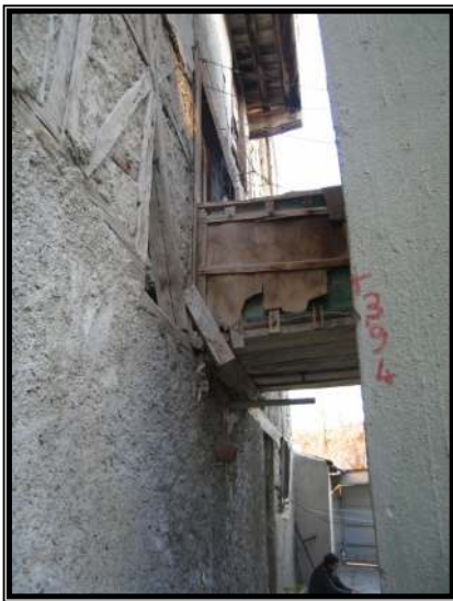
Resim 4.3 Avlu köprü bağlantısı
