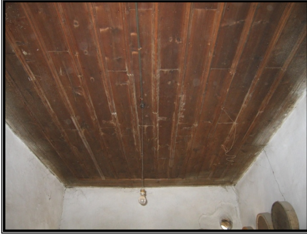
Resim 4.16 Z02 Odası ahşap tavan kaplaması
