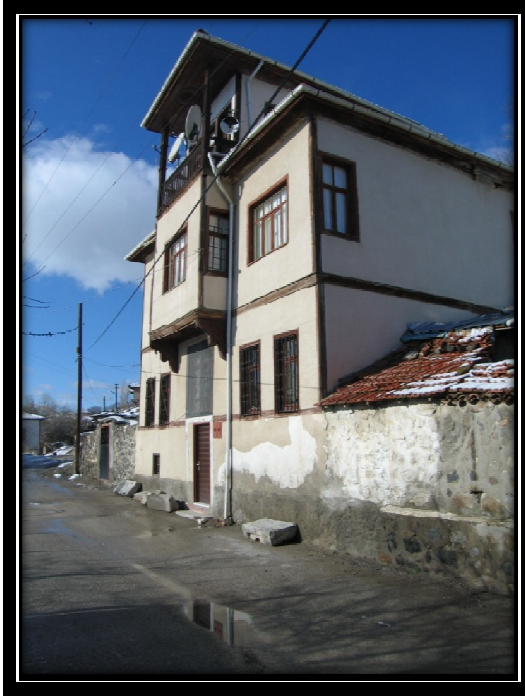
Resim 3.16 Sülüklü Sokak görünüm 7
