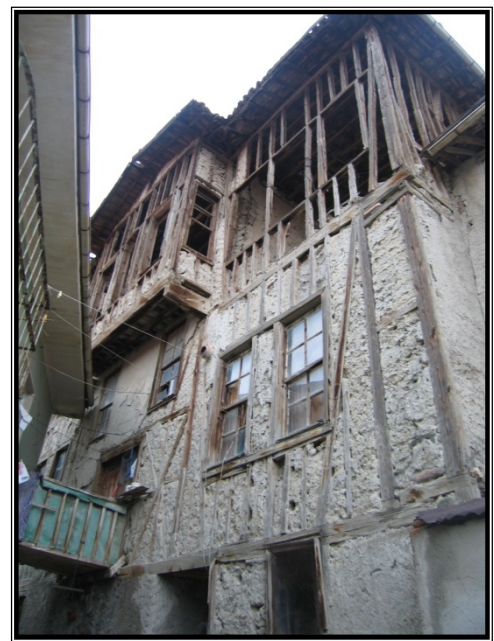
Resim 4.84 Arka cephe ahşap konsol
