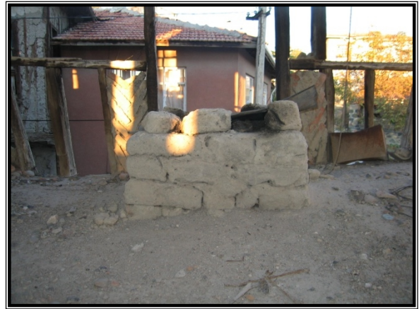
Resim 4.45 105 Oda kerpiç baca kalıntısı
