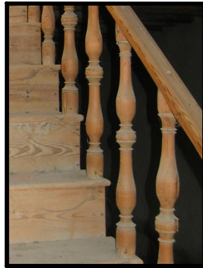
Resim 5.7 Torna merdiven korkuluğu
