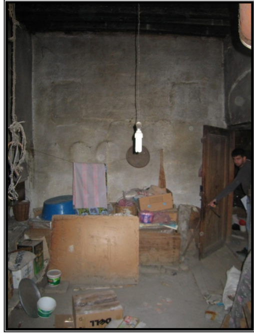
Resim 4.18 Mutfak genel görünüm 2
