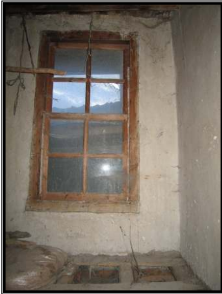
Resim 4.92 P2 pencere iç görünüş
