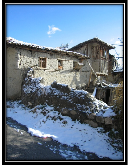
Resim 3.21 Sülüklü Sokak görünüm 12
