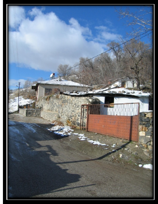
Resim 3.17 Sülüklü Sokak görünüm 8
