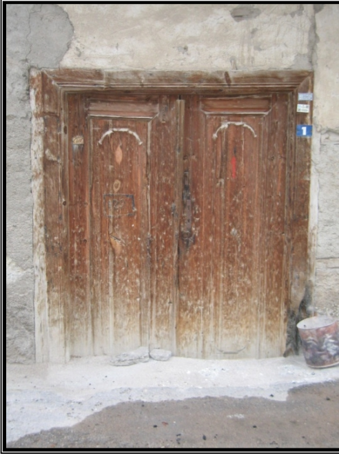
Resim 4.144 DK 1 Kapısı renk değişimi
