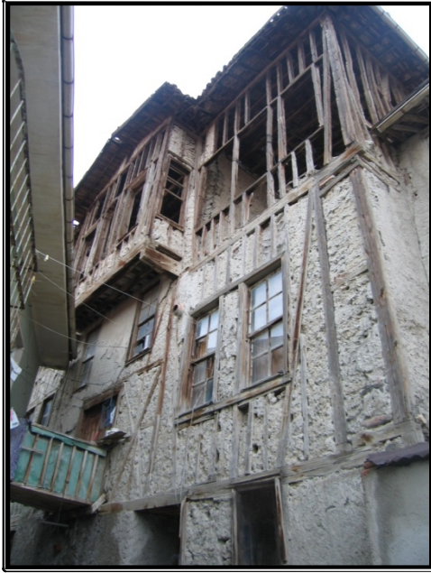
Resim 4.82 Arka cephe ahşap çatkı
