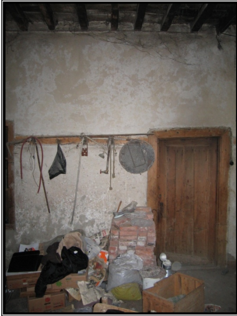
Resim 4.7 Ahşap duvar bantları
