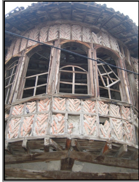
Resim 4.72 Dairesel cumba pencereleri
