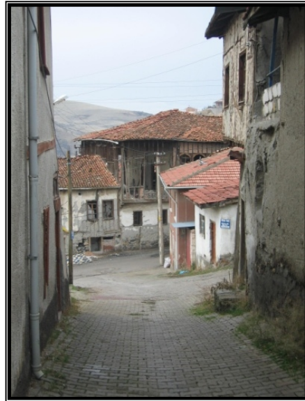
Resim 4.76 Çatı genel görünümü
