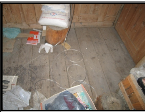
Resim 4.26 ZO5 Odası döşemesi
