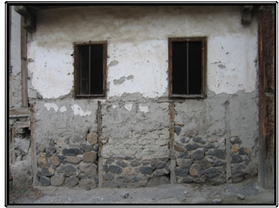
Resim 4.81 Taş duvardaki hatıl ve dikmeler
