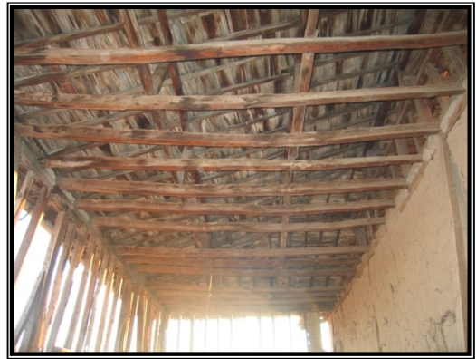
Resim 4.88 Ahşap kirişler 2
