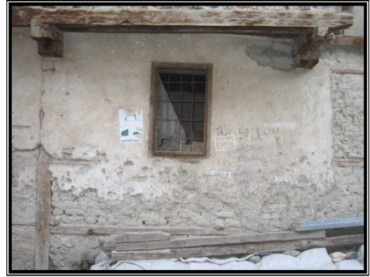
Resim 4.65. Ön cephe zemin kat sağ
