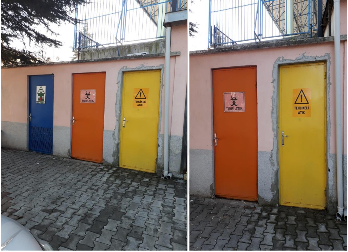
Şekil 4.37. Tıbbi, evsel ve tehlikeli atık geçici depoları.
