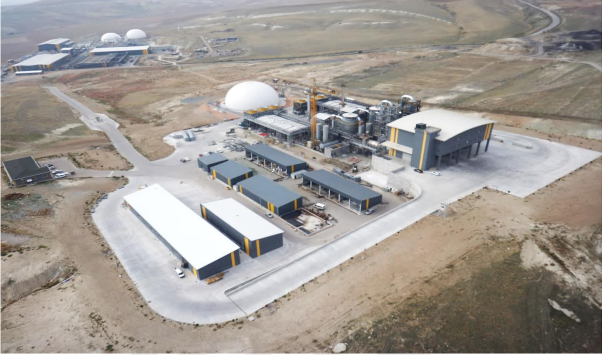
Şekil 4.5. Tıbbi atık yakma tesisi.
