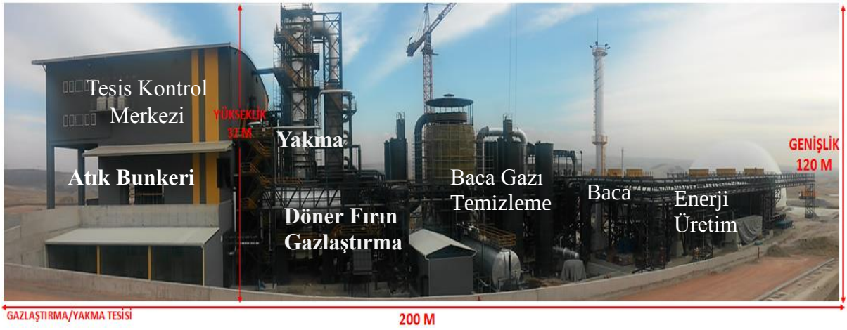
Şekil 4.9. Tıbbi atık yakma tesisi bölümleri.
