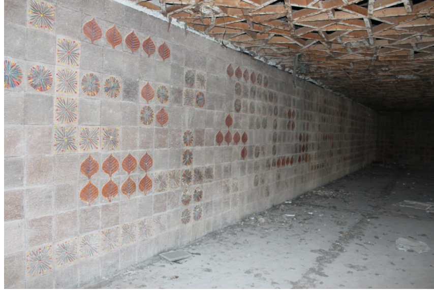
Resim 30. Diren, S. (t.y.). AOÇ Marmara Oteli Duvar Kaplaması [Seramik]
