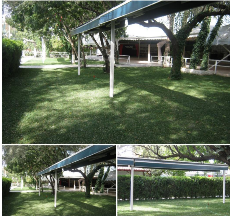
Şekil 4.48. Alan içerisinde bulunan tente
