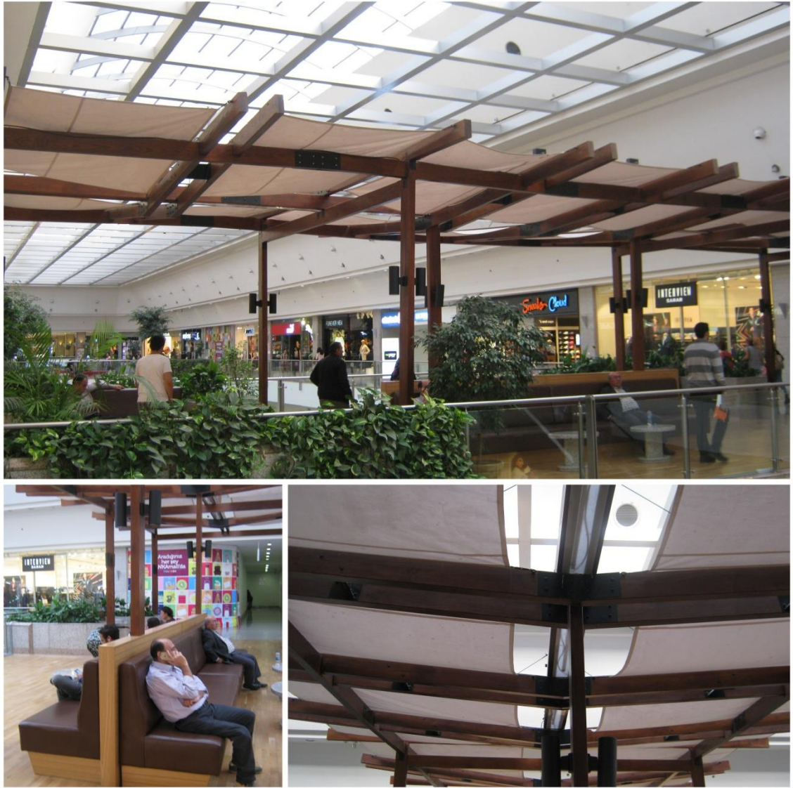
Şekil 4.18. Pergole kullanımı ile park hissi uyandırılmıştır
