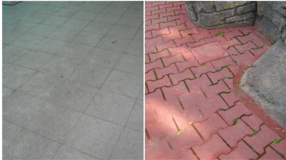
Şekil 4.54. Alan içerisinde kullanılan döşeme elemanları
