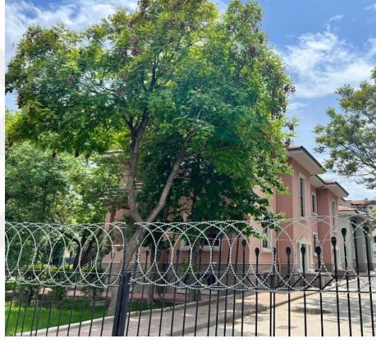
Şekil 4. 8. ve Şekil 4. 9. Medipol Üniversitesi Tarafından Kullanılan Birimlerin Dış Cephe Görünümleri (yazarın arşivinden)
