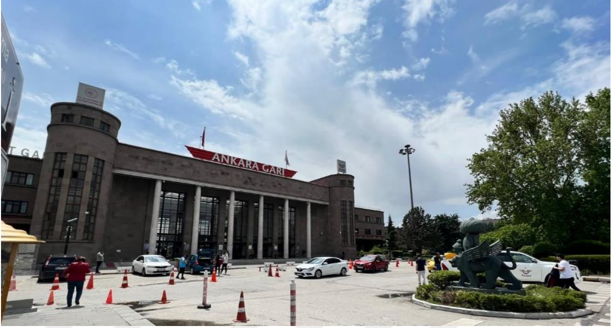
Şekil 4. 18. Ankara Tren Garı Dış Görünüşü (Yazarın arşivinden.)
