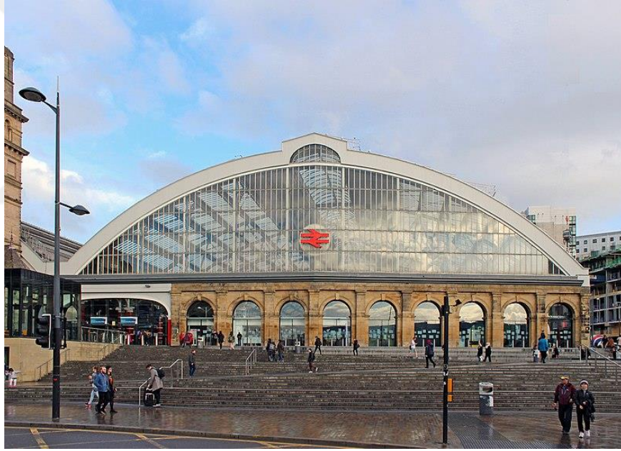
Şekil 2. 8. Liverpool Lime Caddesi İstasyonu Güncel Görşeli [30]
