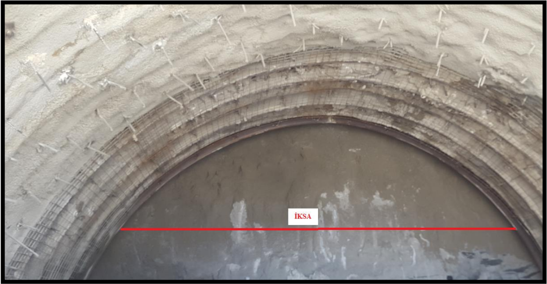
Şekil 4.32. İnceleme alanı T4-tünelindeki iksa (Ø – 160) montajı
