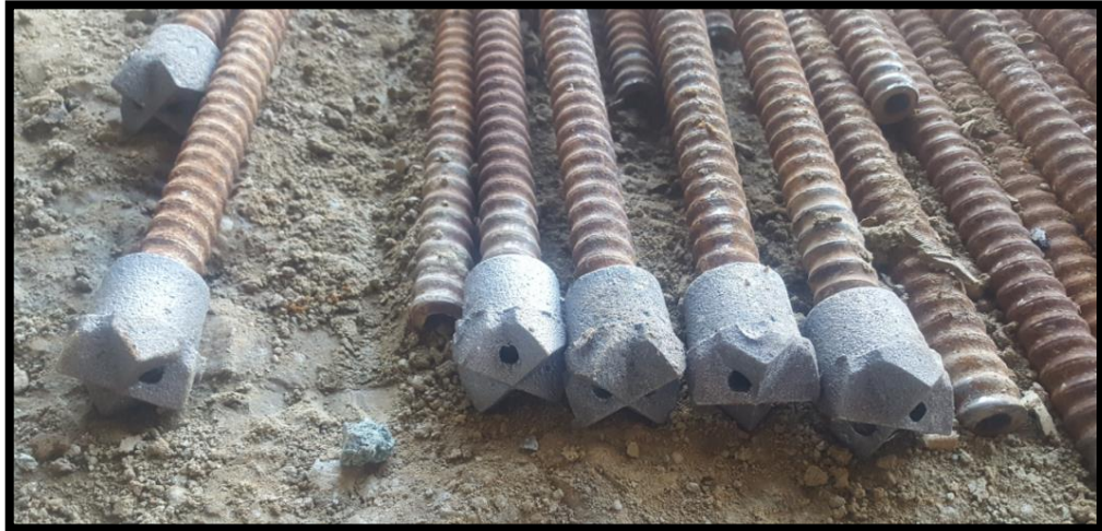
Şekil 4.49. İnceleme alanı T4 Tüneli ibo bulon hazırlığı
