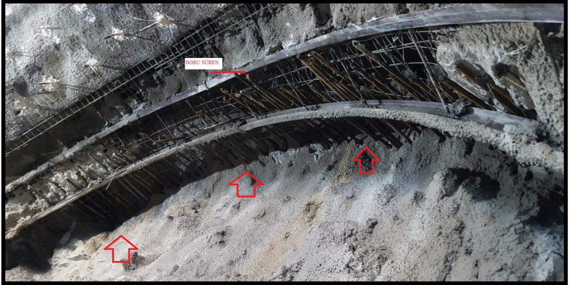
Şekil 4.37. İnceleme alanı T4 Tüneli boru süren uygulaması
