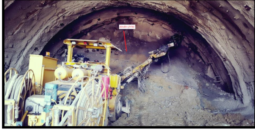
Şekil 4.39. İnceleme alanı T4 Tüneli zemin çivisi uygulaması
