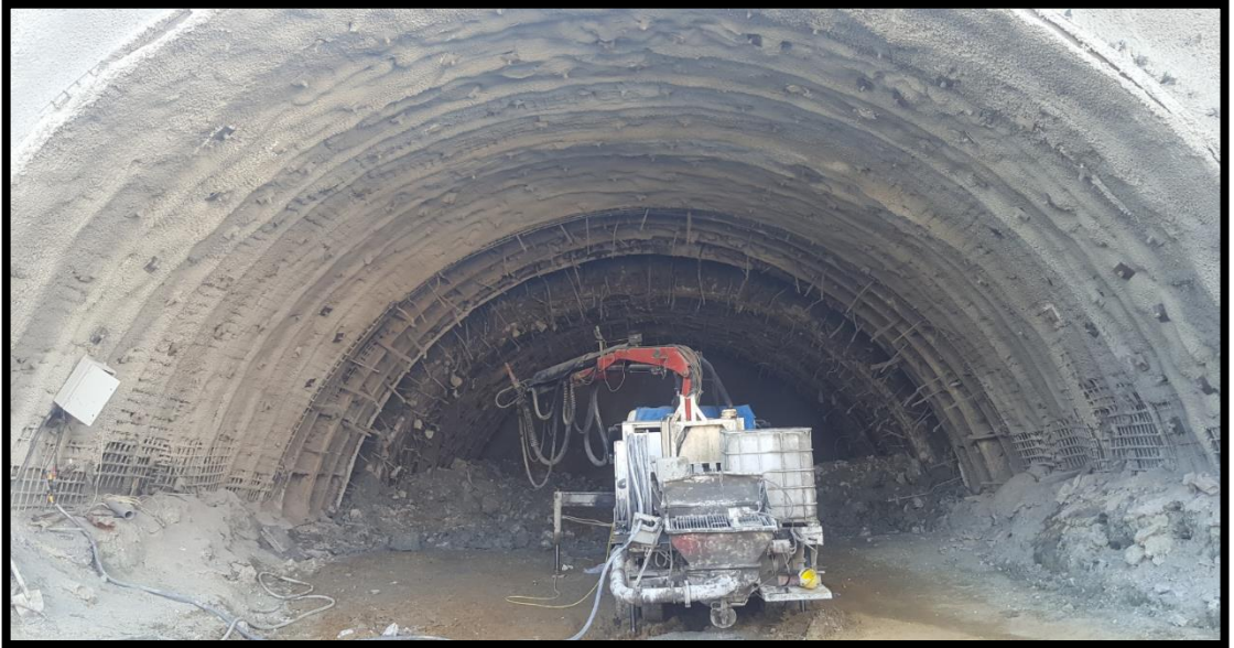
Şekil 4.41. İnceleme alanı T4 Tüneli Püskürtme Beton Uygulaması
