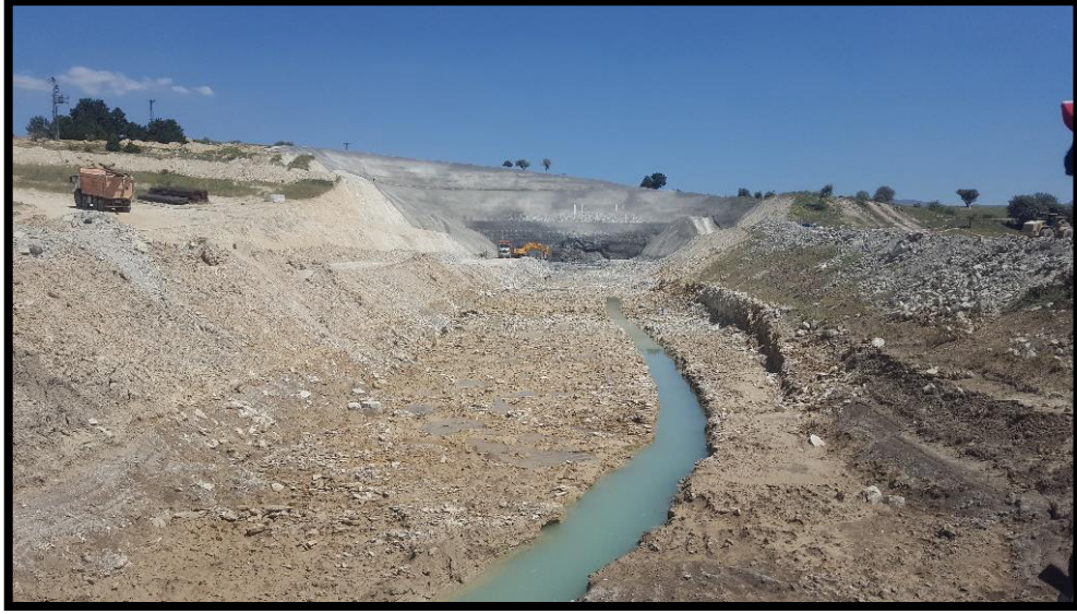
Şekil 4.5. Tünel alanı güzergah görüntüsü
