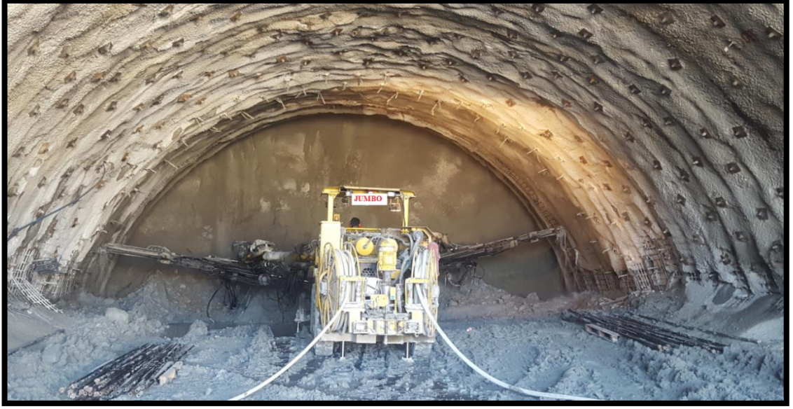
Şekil 4.31. Tünel içerisinde Jumbo çalışması
