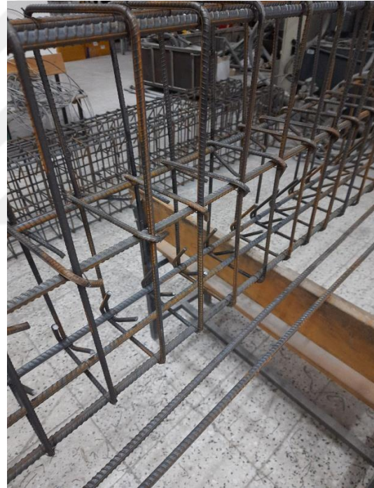
Şekil 12. Donatıların hazırlanması
