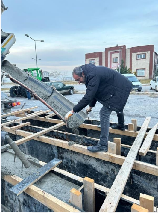
Şekil 14. Beton dökümü
