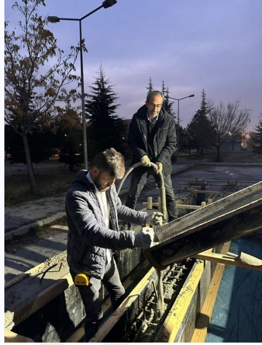
Şekil 14. Beton dökümü
