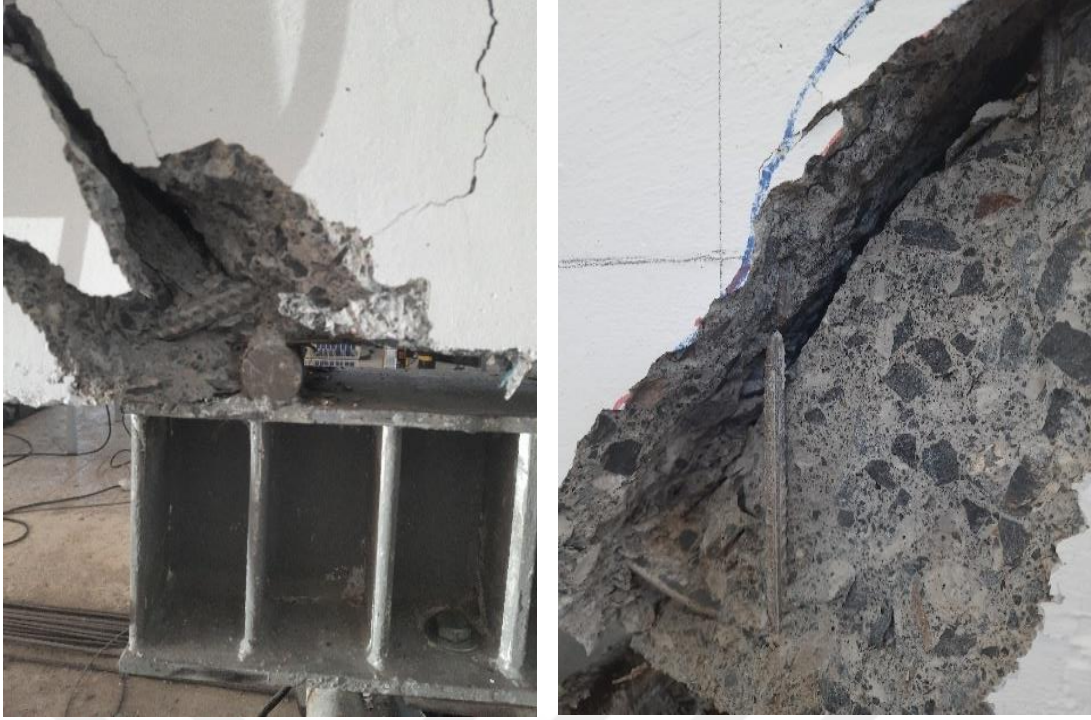
Şekil 39. BK-Ç40 kirişinin deney sonundaki etriye kopması hasar oluşumu
