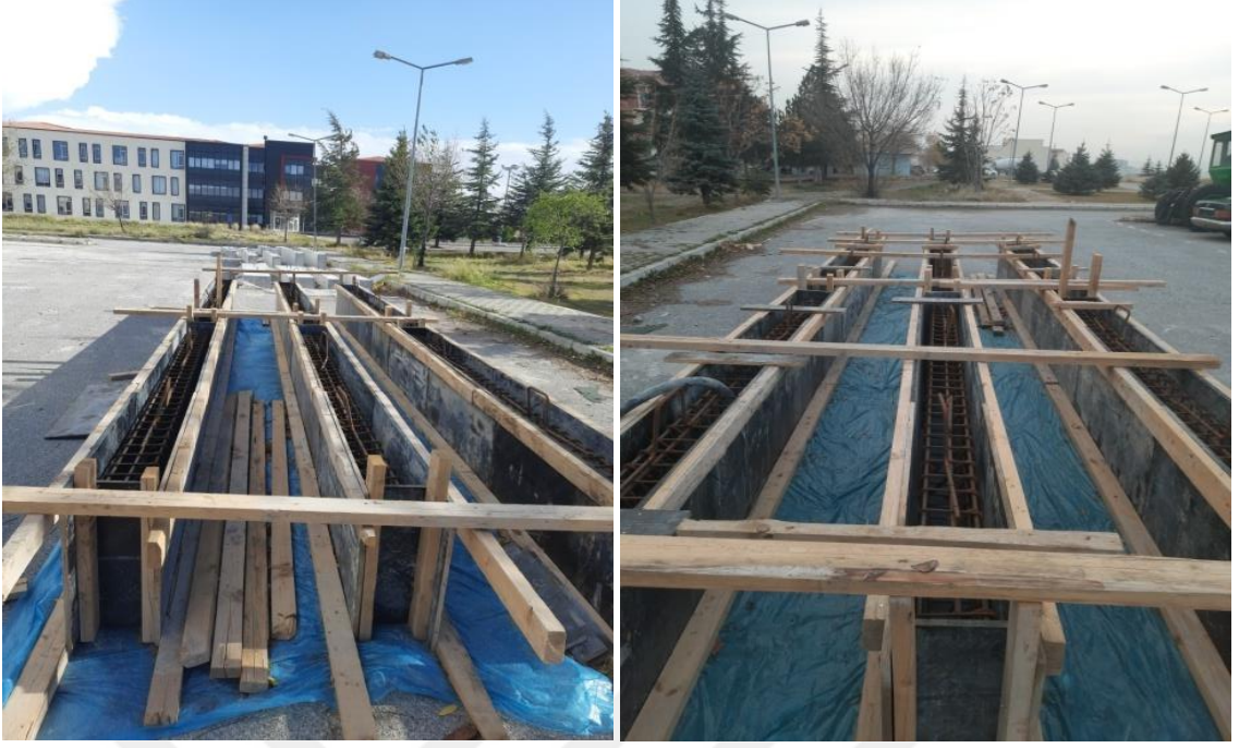
Şekil 13. Kalıplara donatı yerleşimi
