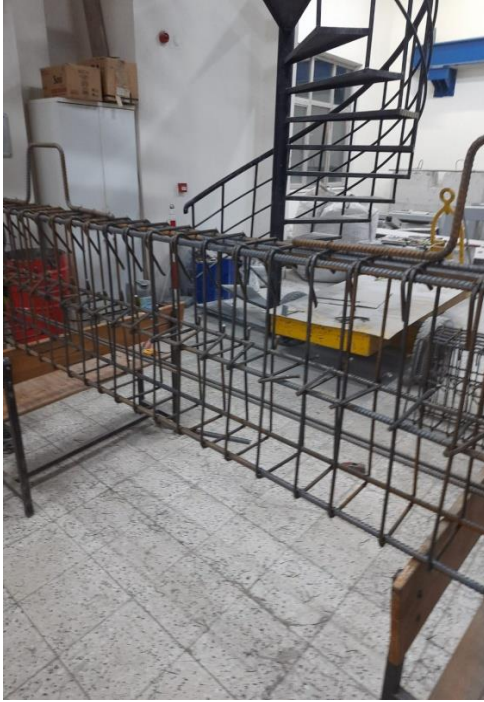
Şekil 12. Donatıların hazırlanması
