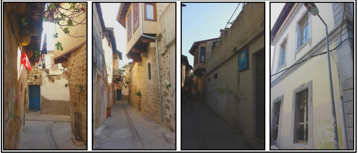
Şekil 59: Gazipaşa Caddesi [C] zone mevcut durumu.
