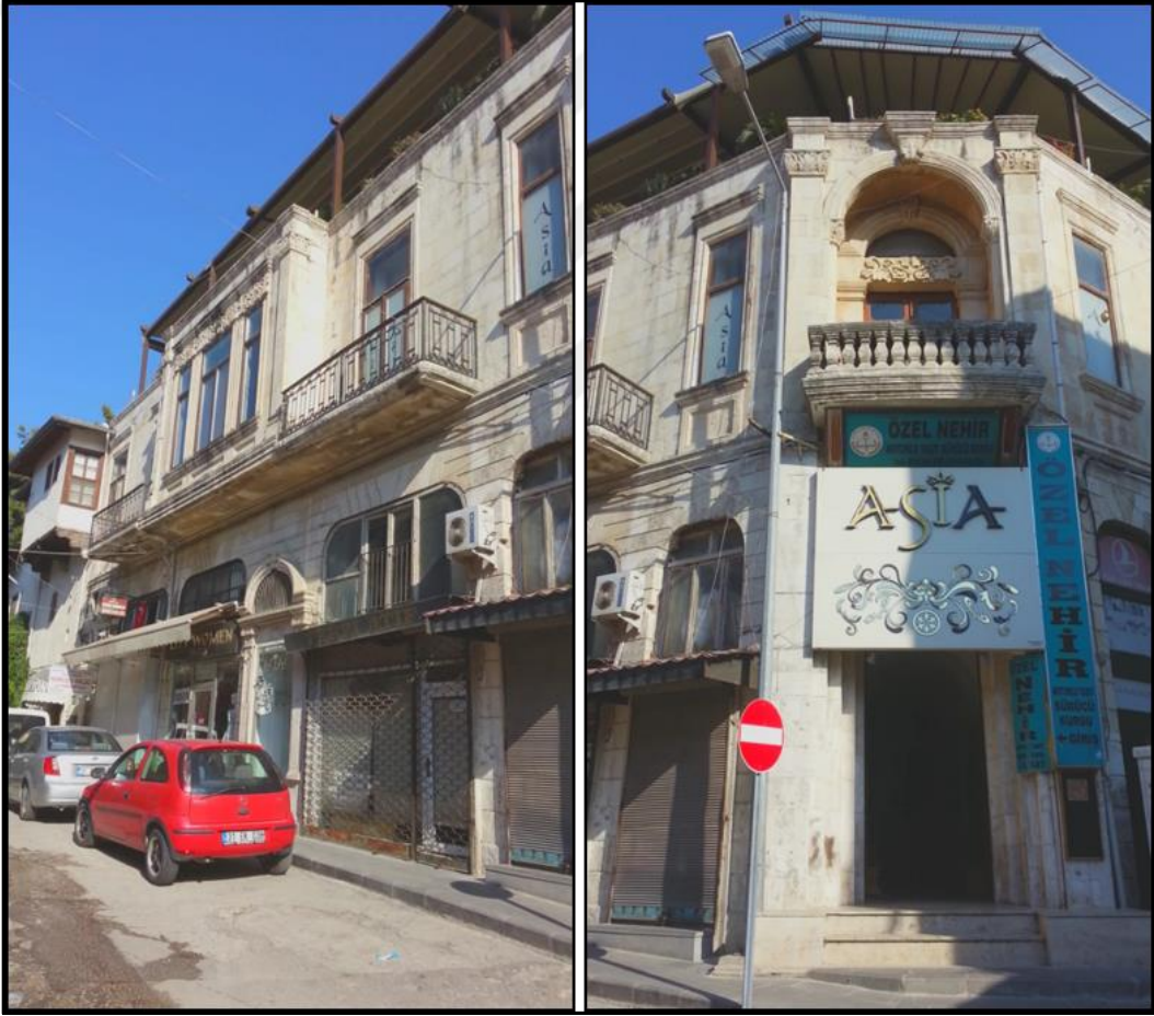
Şekil 90: Gazipaşa Caddesi'nde bulunan tarihi yapı.
