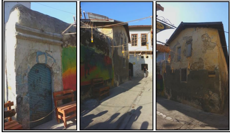
Şekil 63: Gazipaşa Caddesi [E] zonu mevcut durumu.
