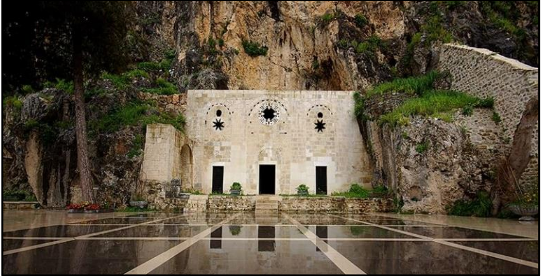
Şekil 20: St. Pierre Kilisesi ( URL-17, 2016).
