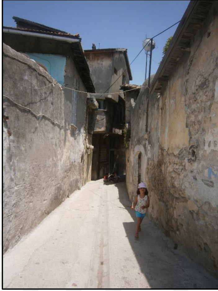
Şekil 36: Oğuzlar Caddesi'nde uygulanmış beton döşeme örneği.
