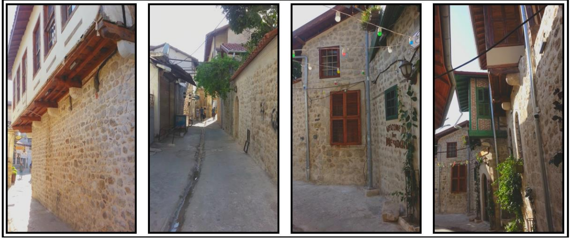
Şekil 61: Gazipaşa Caddesi [D] zonu mevcut durumu.
