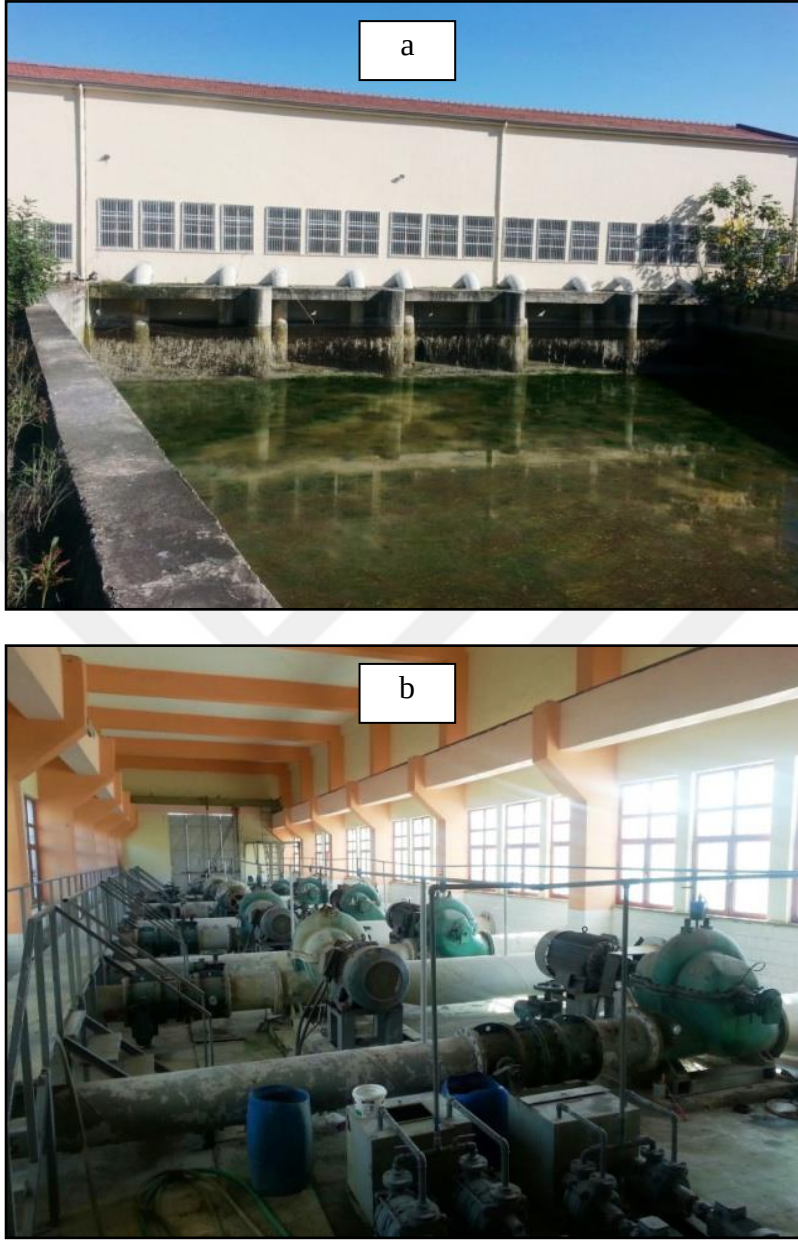
Şekil 3.7. Döşemealtı Pompaj Sulama Birliği a) Yaklaşım havuzu fotoğrafı; b) Ana bina pompa fotoğrafı
