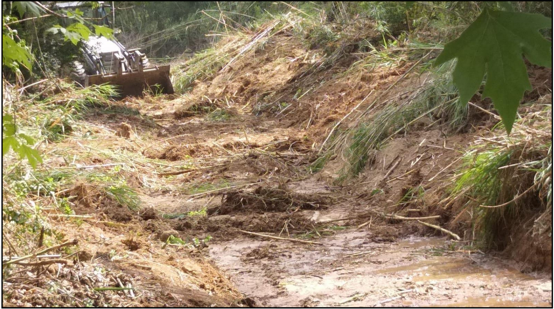
Şekil 3.5. Karaman Duraliler Sulama Birliği'nde bakım-onarım faaliyetleri
