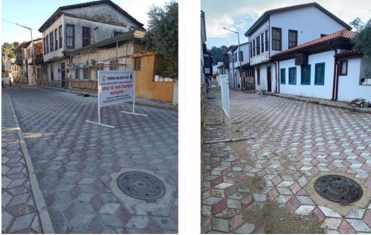
Şekil 4.51. Sokak Sağlıklaştırma Çalışması; a) Çalışmadan önce b) Çalışmadan sonra
