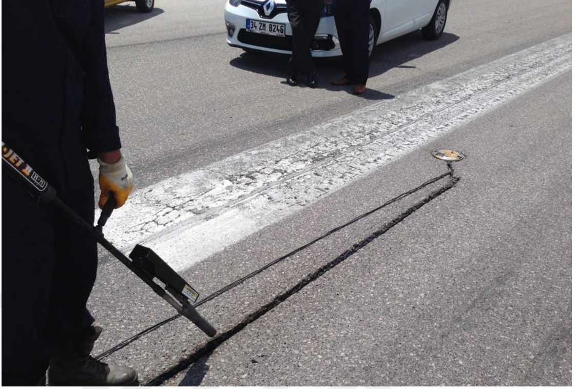
Şekil 2.7. Derz Çatlağı ve Tamiri ( http://www.asfaltkaplama.com/hizmetler/catlak-tamiri-derz-dolgusu )
