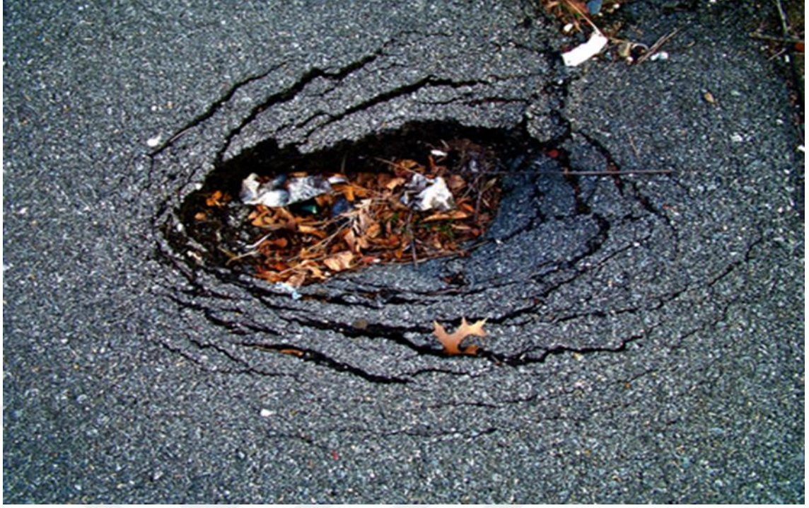
Şekil 2.19. Sökülme ( https://www.movea.com.tr/asfalt-bozulmalari-neden-olusur/ )
