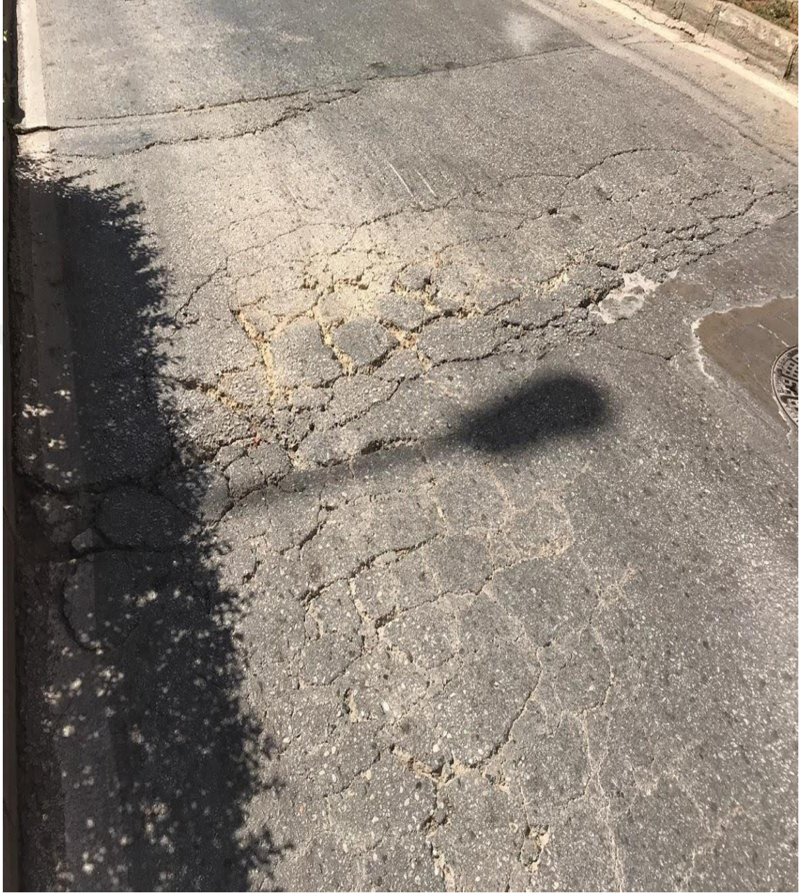
Şekil 4.12. (1) Memurevleri Mahallesi Güllük Caddesi
