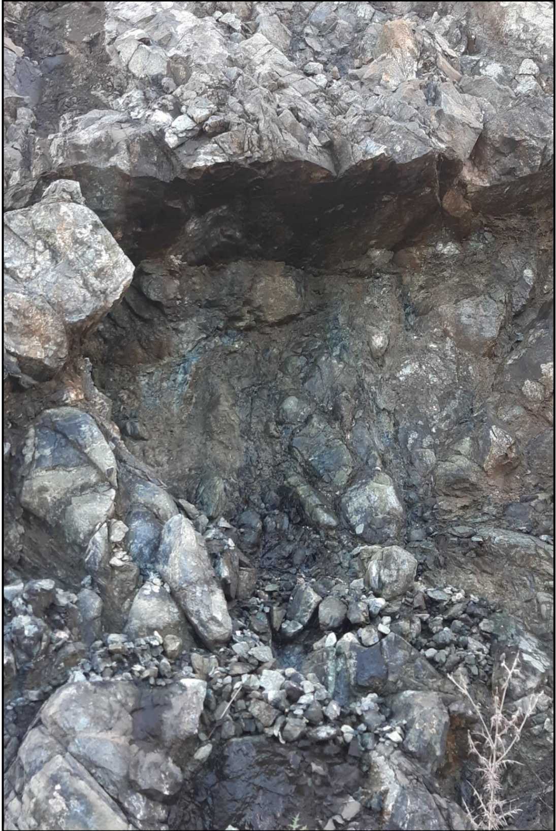
řekil 4.19. A6-sınıfı řevine ait devrilme alanının yakından görünümü
