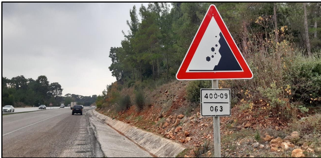
Şekil 4.5. Bölgedeki kaya düşmelerine duyarlı olduğunu gösteren uyarı levhası
