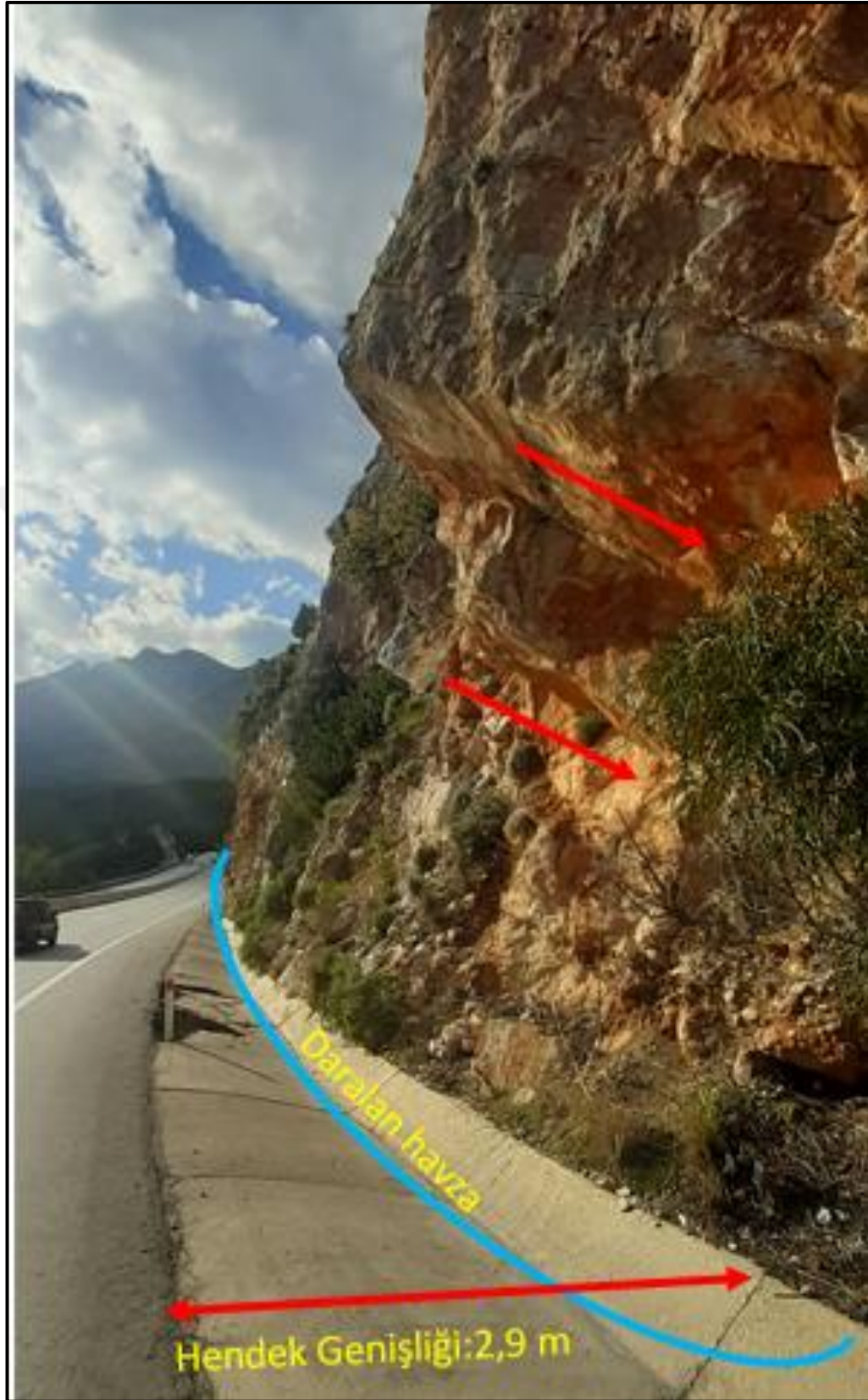
Şekil 4.17. A5-sınıfı şevi görüntüsü (Kemer istikameti)
