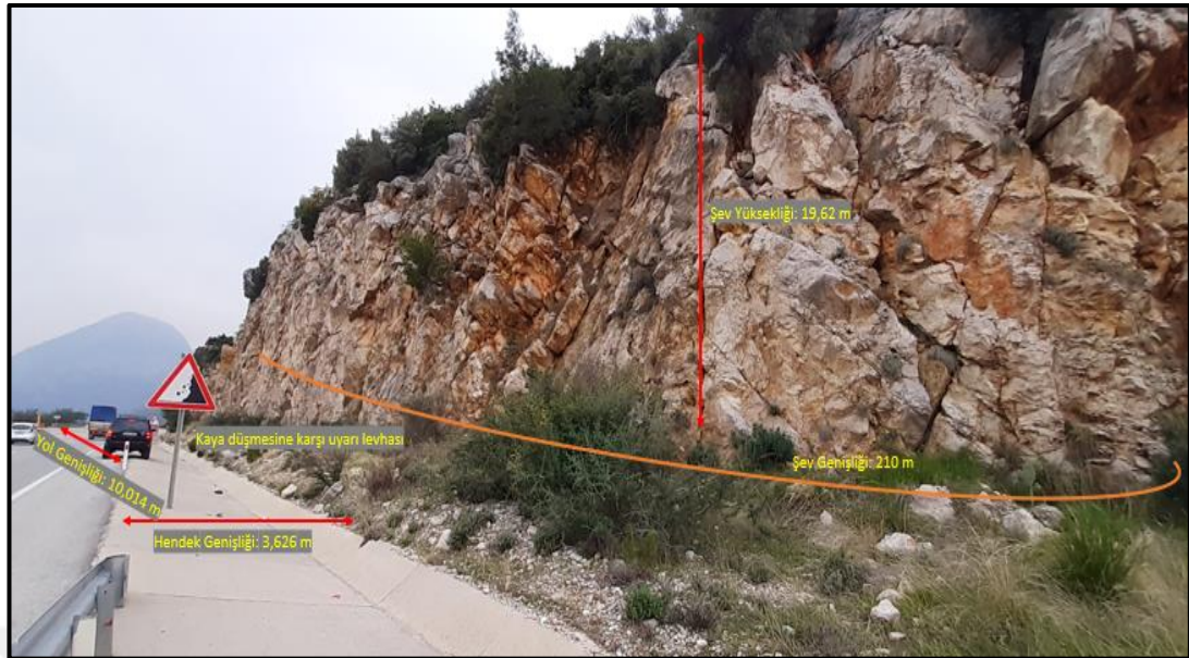
Şekil 4.13. A4-sınıfı şevinin genel görünümü
