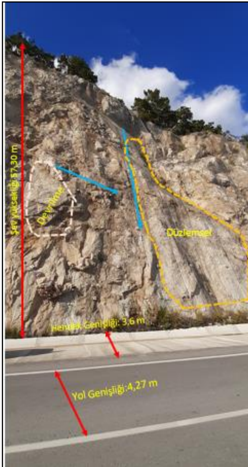
Şekil 3.1. D-400 karayoluna ait 3. bölgede yer alan A-sınıfı şevinin görünümü
