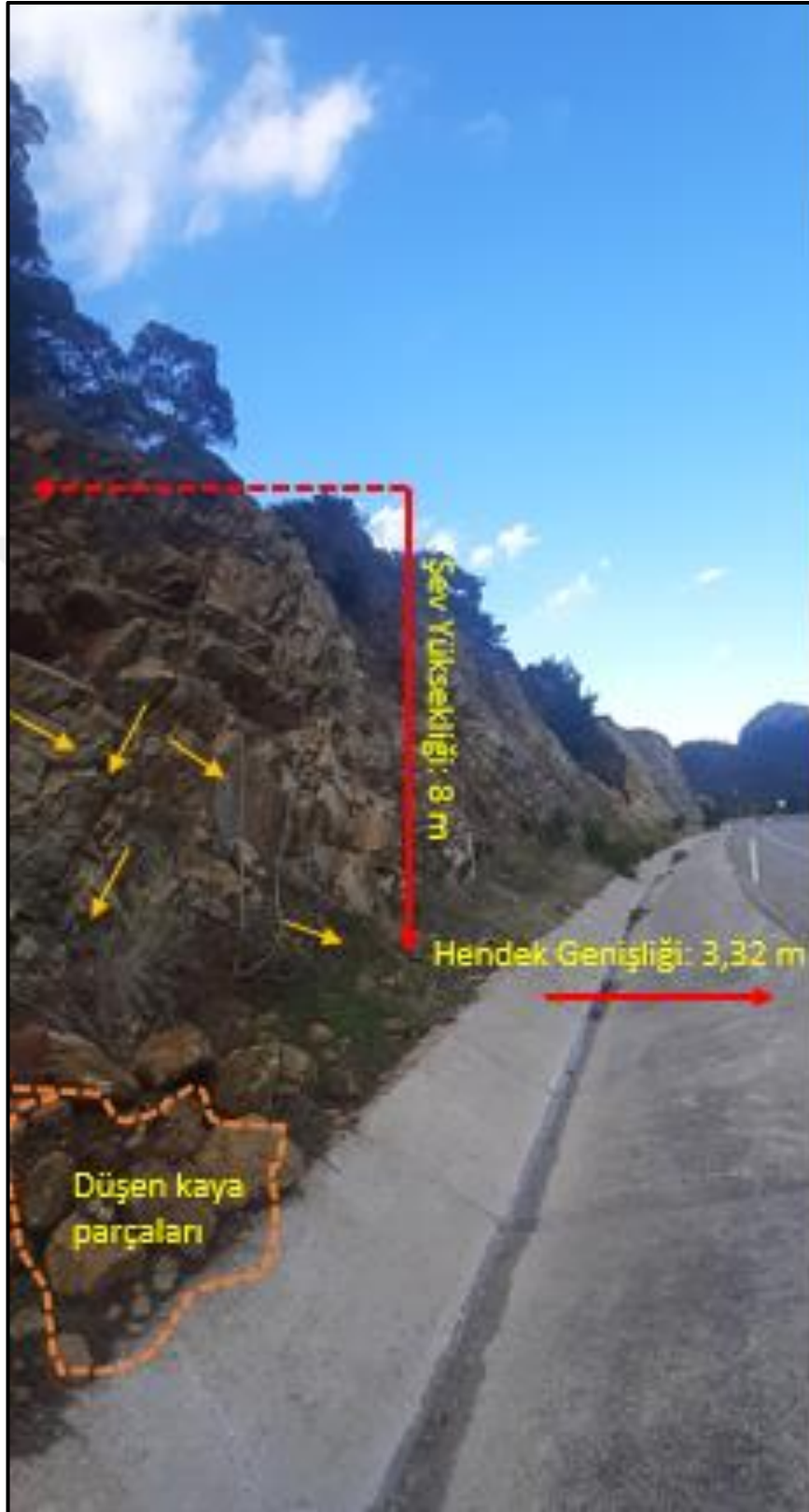
Şekil 3.2. D-400 karayoluna ait 9. bölgede yer alan B-sınıfı şevinin görünümü
