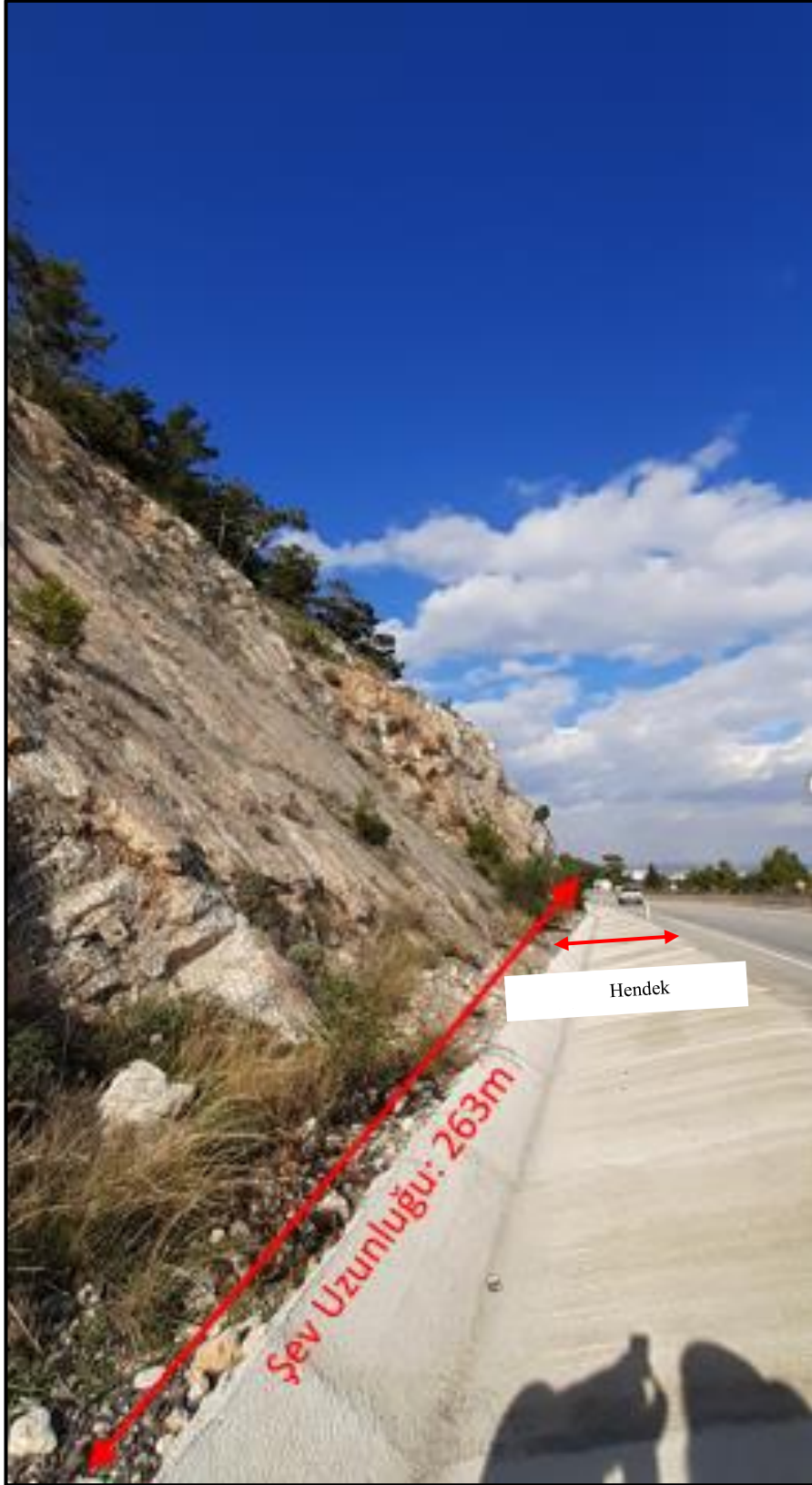
Şekil 4.7. Çalışma alanına ait 1. bölgede yer alan karayolu şevinin görünümü
