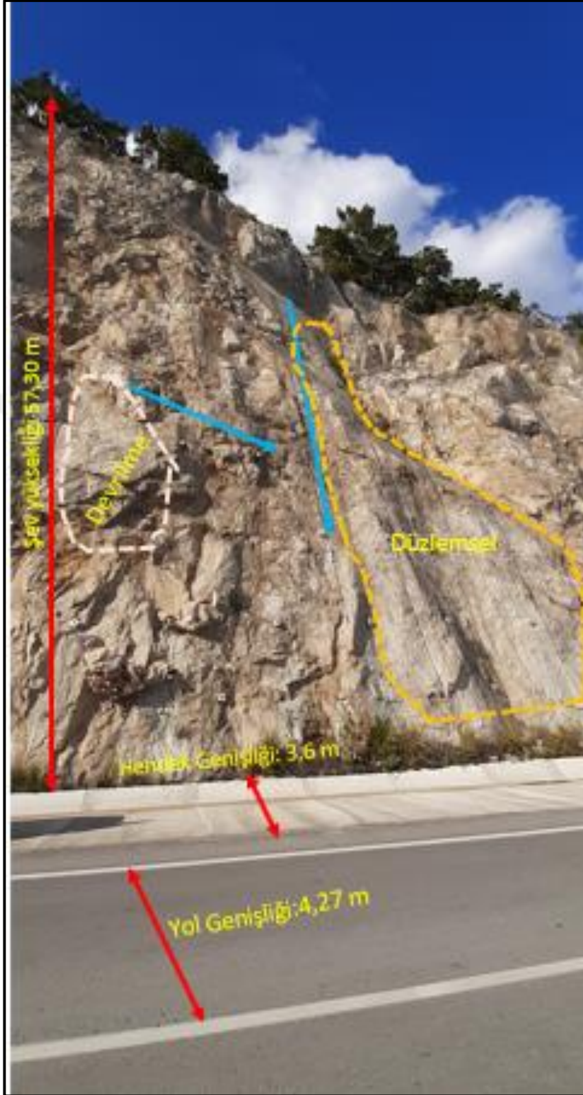
řekil 4.12. A3-sınıfı řevin özelliklerini gösteren řekil. sarı kesikli çizgi ile belirtilmiş olan alanda bozunma sebebi ile döküntü şeklinde yenileceęi kaya yüzeyini göstermektedir. Mavi renk ile gösterilen oklar tabakalanma yönlerini göstermektedir.
