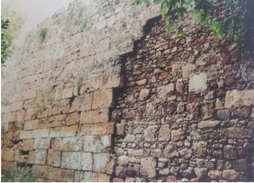
Şekil 4.19. Bizans Dönemi tamiratlarını gösteren surlar üzerindeki katmanlı yapı (Yılmaz 2002)
