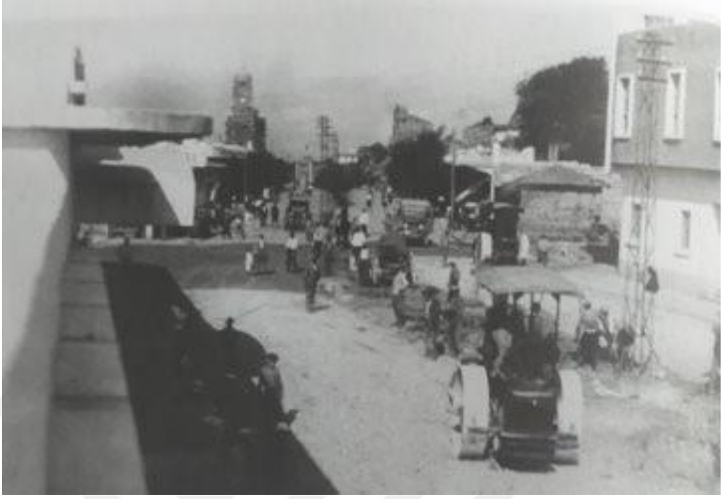
Şekil 4.42. Aliçetinkaya Caddesi yol yapım çalışması (Çimrin 2007b)
