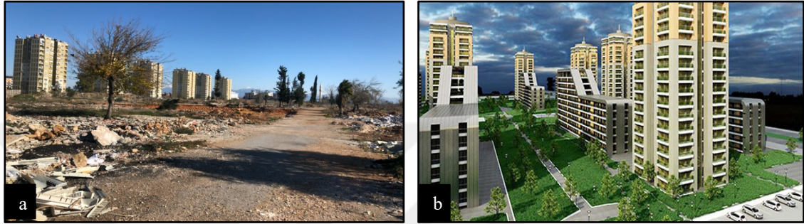
Şekil 4.7. Güneş Mahallesi kentsel dönüşüm projesinden görünüm a) Yıkım sonrası (Orijinal 2020) ve b) Yapımı planlanan projenin üç boyutlu görseli (Anonim 8)
