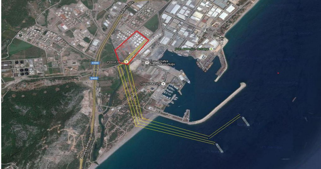
Şekil 3.2. Antalya Körfezi denizde petrol boru hatları kaynağı (Anonim 20 2020)
