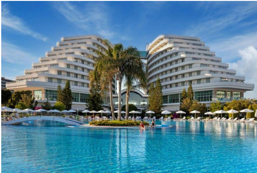
Şekil 4.35. Miracle Otel genel görünüm (Anonim 22)
