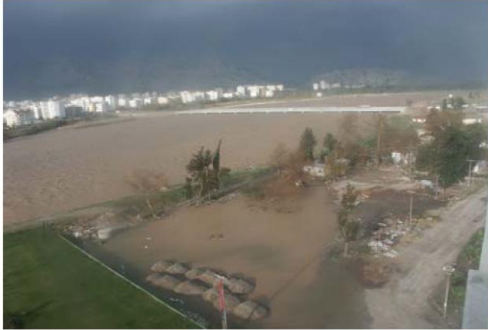
Foto 16 Boğaçayı Köprüsünden Taşkın Sonrası Görünüm
