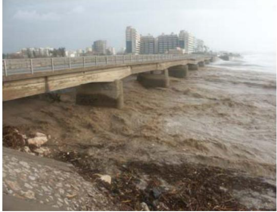
Foto 15 Boğaçayı ve Karaman Çayının Taşkın Anındaki Görünüşü
