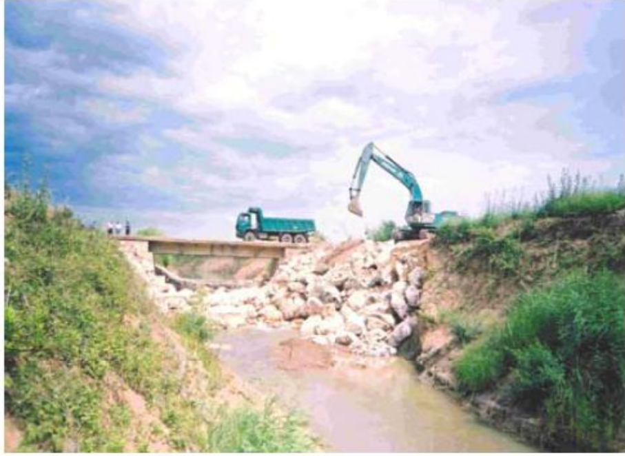
Foto 11 DSİ 13. Bölge Müdürlüğünün Sedde ve Yatak Çalışmaları
