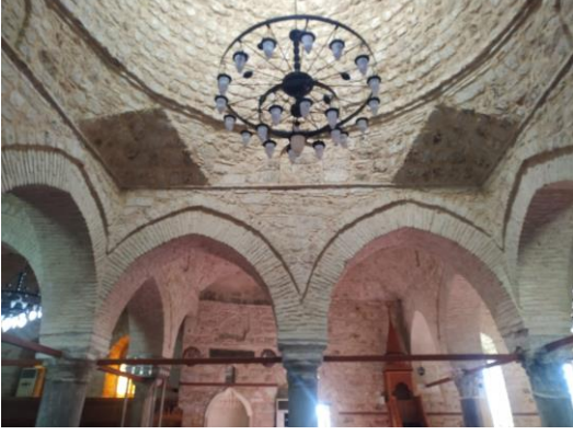
Şekil 44: Kemerler (Melek Ersoy Arşivinden 2023)
