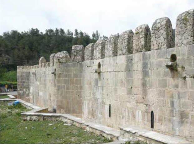
Şekil 69: Onarımdan sonra Alara Han güney cephesi (Bakkal, 2019:551)
