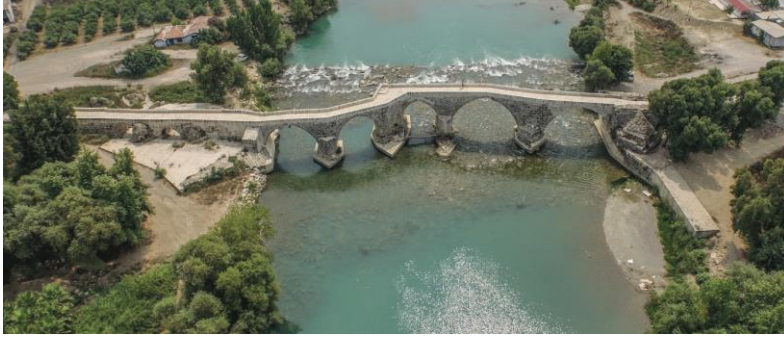
Şekil 89: Belkıs Köprüsü (URL 16)
