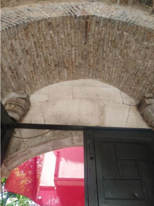
Şekil 12: Karatay Medresesi Giriş Kapısı İçten Görünümü (Melek Ersoy Arşivinden 2023)
