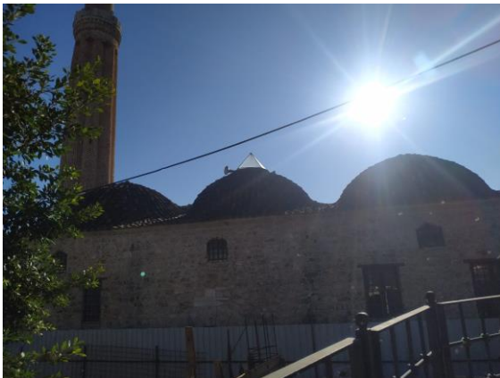
Şekil 31: Sağ Cephe görünümü (Melek Ersoy Arşivinden 2023)
