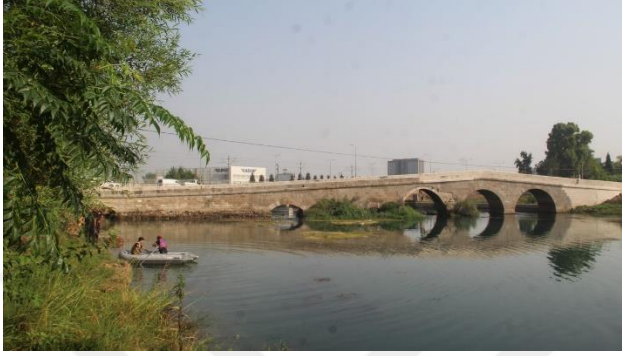
Şekil 88: Düden çayı Köprüsü (URL 14)
