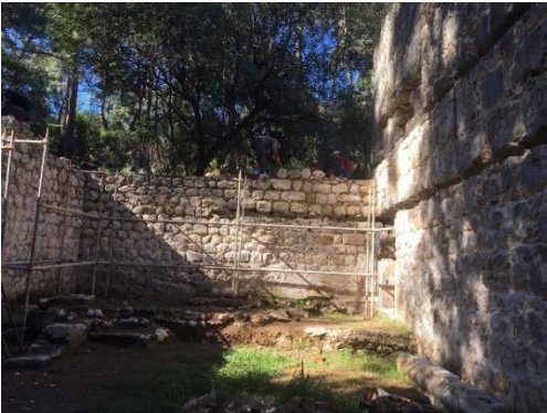
Şekil 120: Taş Duvar Restorasyonu (Antalya Yatırım İşleme ve Koordinasyon Başkanlığı Arşivinden)
