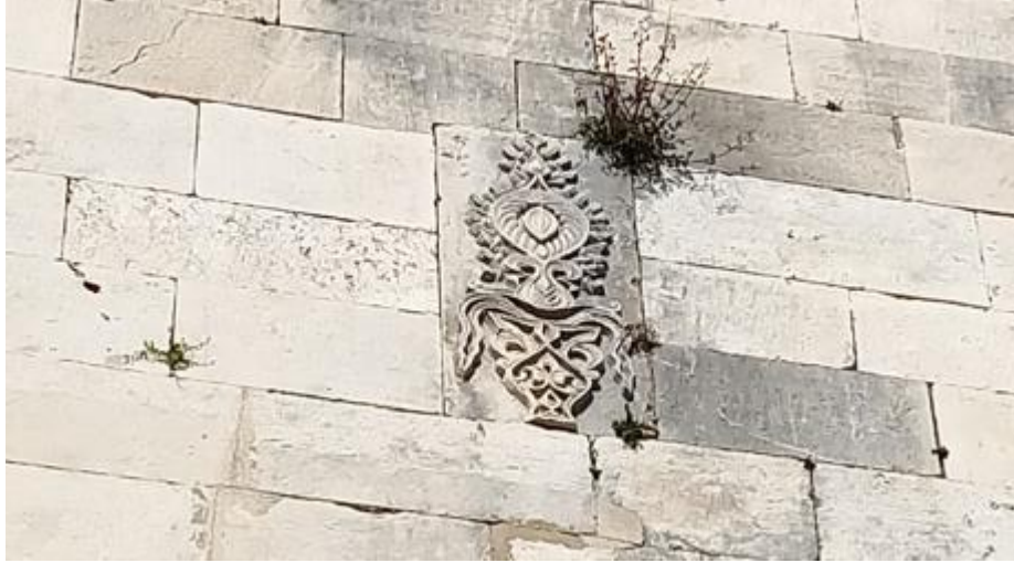
Fotoğraf 3. 179 Güney Duvarındaki Süsleme
