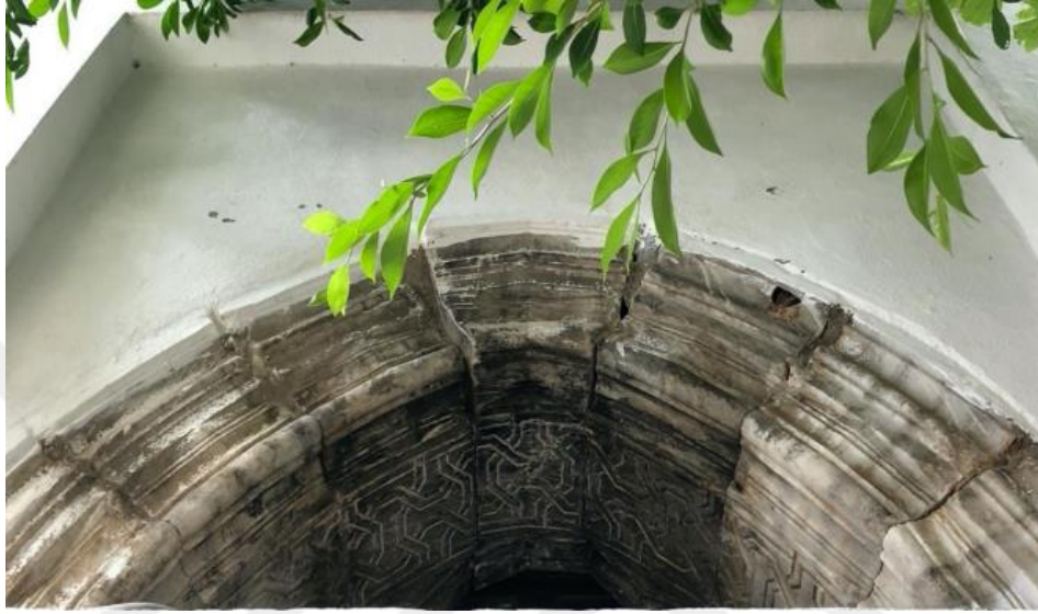
Fotoğraf 3. 2 Batı Cephesi Kemer Açıklığı
