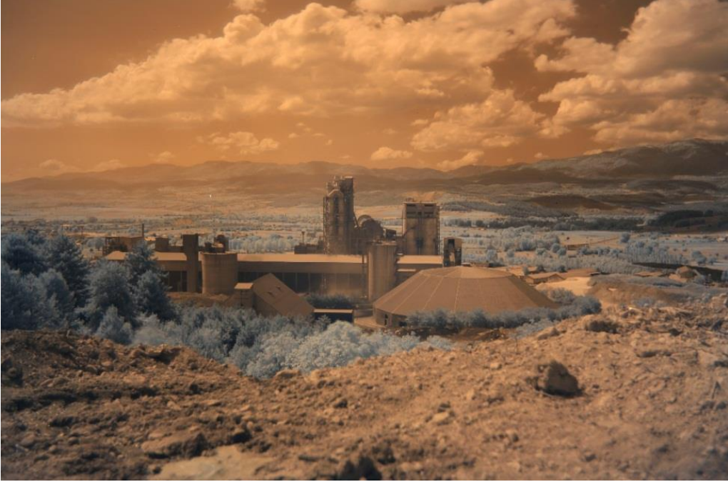
Görsel 64: Mahmut Rıfki Ünal, Çimento Fabrikası, Bolu (2020)
