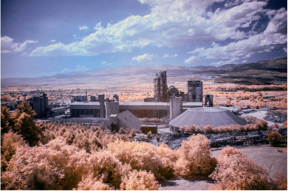
Görsel 71: Mahmut Rıfki Ünal, Çimento Fabrikası, Bolu (2020)
