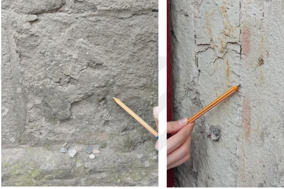
Şekil 78. Katman katman dökülme örnekleri (Hoca Halil Camii ve Ortahisar Mescidi) (yazar arşivi).
