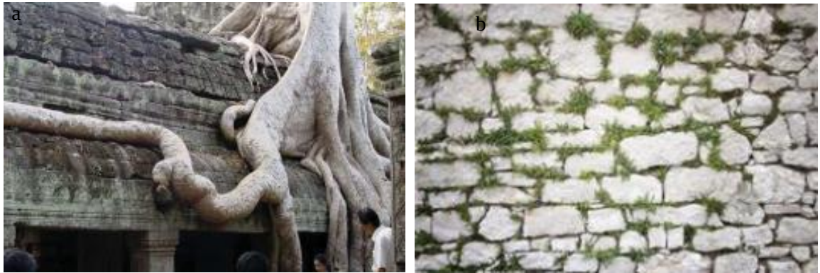
Şekil 25. (a) Taşyapıyı saran ağaç, (b) derz arasında ot oluşumu (Hasbay ve Hattap, 2017).
