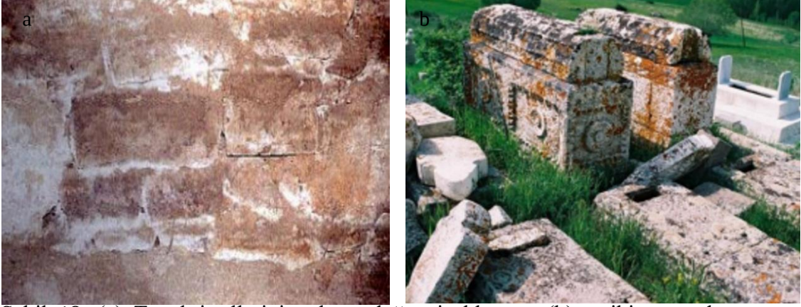
Şekil 18. (a) Tuz kristallerinin oluşturduğu çiçeklenme, (b) tarihi mezarda sarı renk çiçeklenme (Hasbay ve Hattap, 2017).
