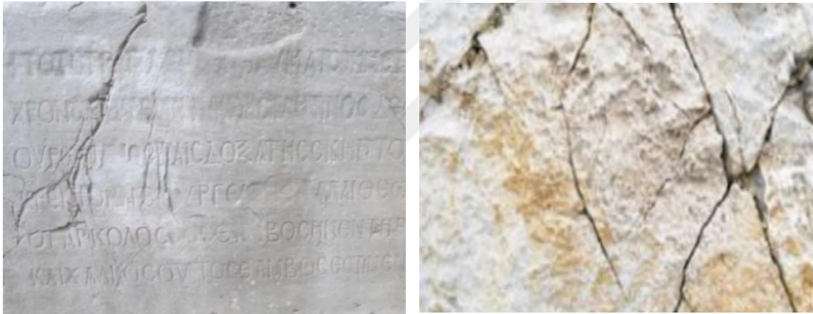
Şekil 12. Sultanahmet'te bulunan hipodromun ortasındaki örme dikilitaşının kaidesinde gözlenen çatlaklar dizisi ve Şekil 13. Taş malzemedede oluşan çatlaklar (Öcal ve Dal, 2012).
