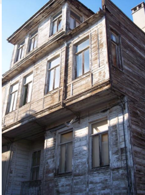
Şekil 4. Ahşap malzeme örneği (Bozkurt, 2008).
