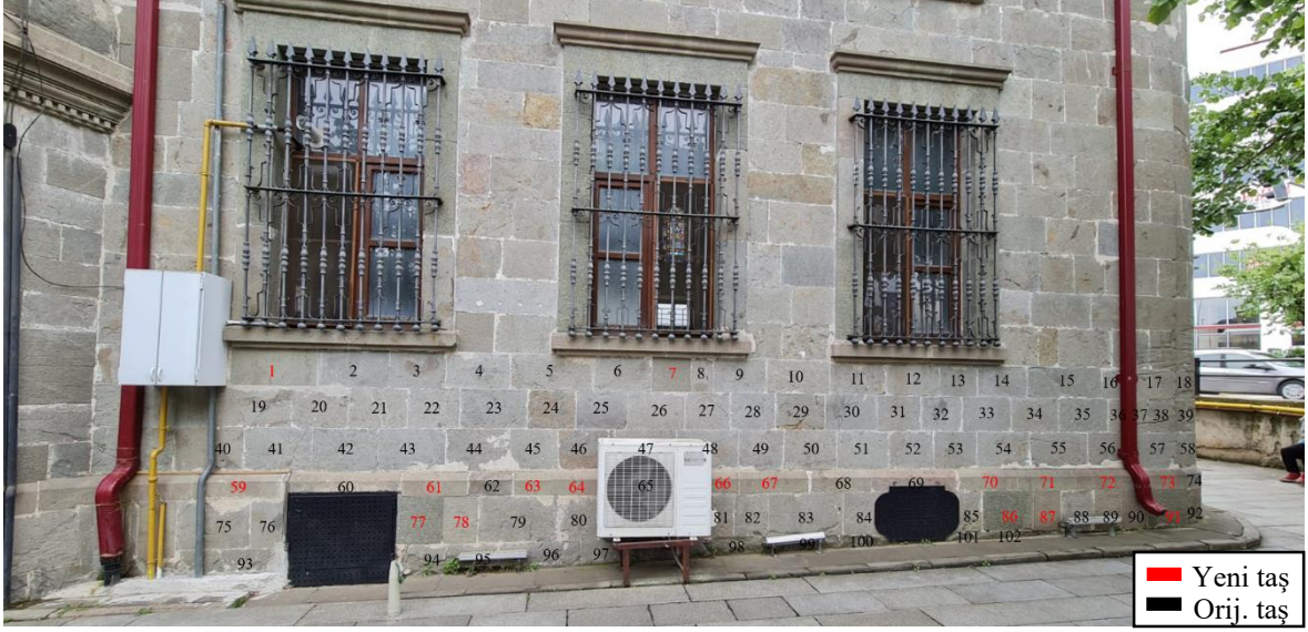
Şekil 80. Hacı Kasım Camii Batı cephesi beden duvarında Schmidt çekici uygulanan taşlar ve numaralandırılması
