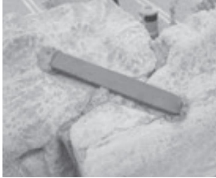
Şekil 5. Metalin kenet bağlantısında kullanımı (Kurugöl ve Küçük, 2015).
