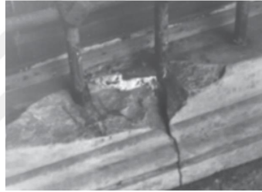
Şekil 19. Demir kenetlerin dış duvar yüzeyindeki konumu ve Şekil 20. Mermer sövede parça kopması (Küçükaya, 2019).
