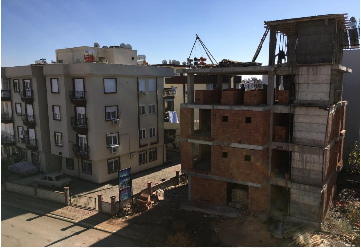
Fotoğraf 13. Ahatlı Mahallesi'nde henüz yapımı devam eden bir apartman inşaatı
