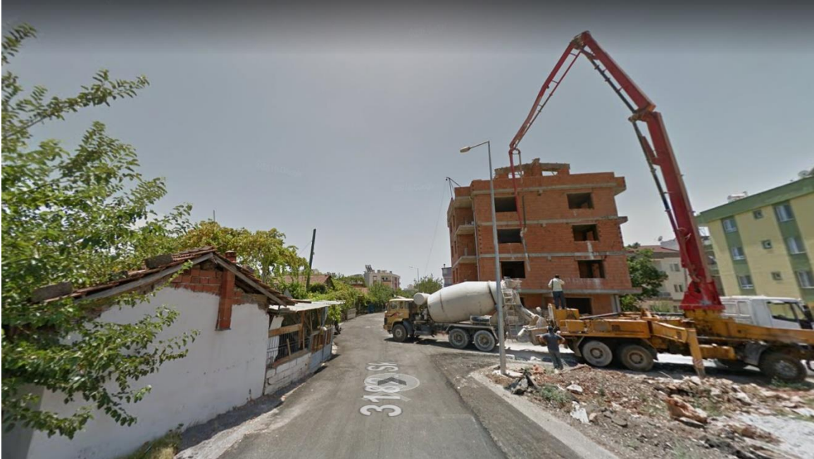
Fotoğraf 4. Yenidoğan Mahallesi'nden bir gecekondü ve yapımı devam eden bir apartman inşaatı
