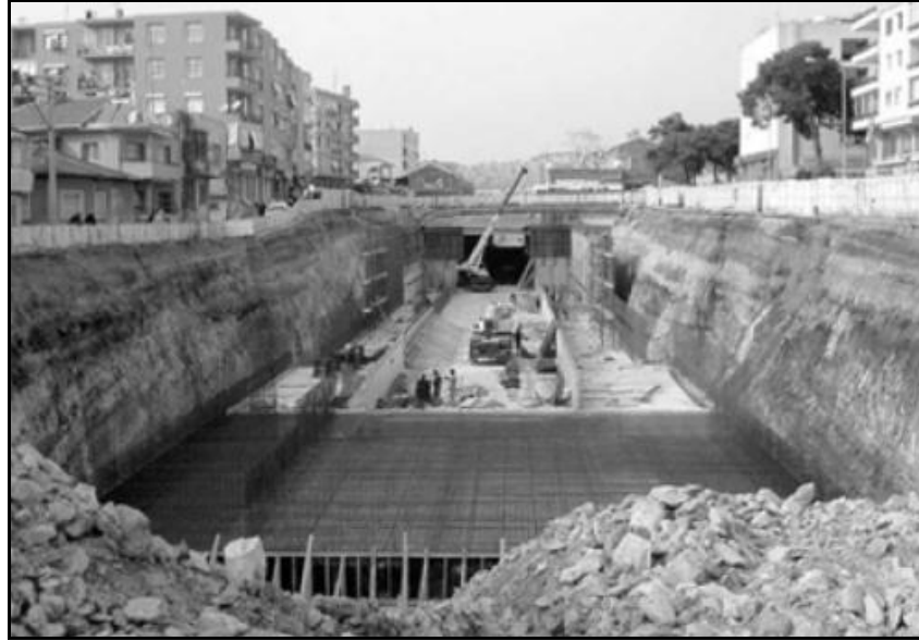
Şekil 4.10 İzmir Banliyö Sistemi, Karşıyaka Tüneli Yapım Çalışmaları (Uluslararası Toplu Taşımacılar Birliği, 2011)
