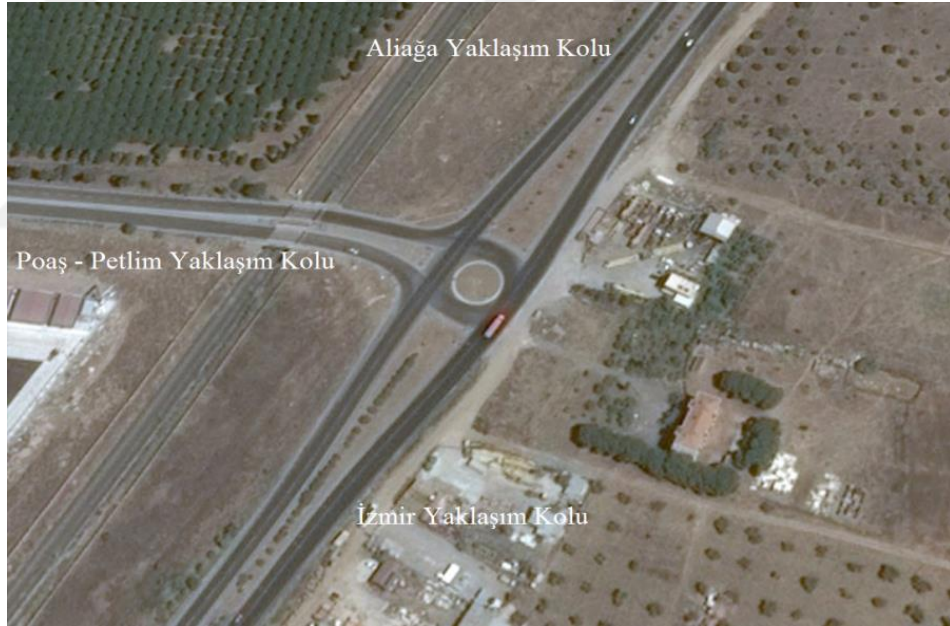
Şekil 5.5 POAŞ kavşağı (Google Earth, 2017)
