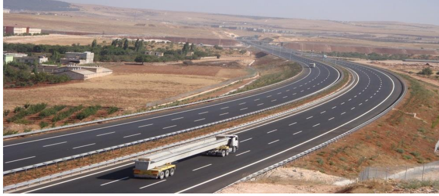
Şekil 4.1 Bölünmüş çok şeritli karayolu – Gaziantep - Şanlıurfa Otoyolu (KGM, 2009)
