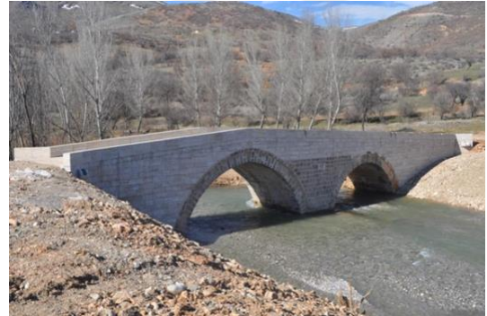
Resim 2.40. Tarhanik Köprüsü (Restorasyon Sonrası)
