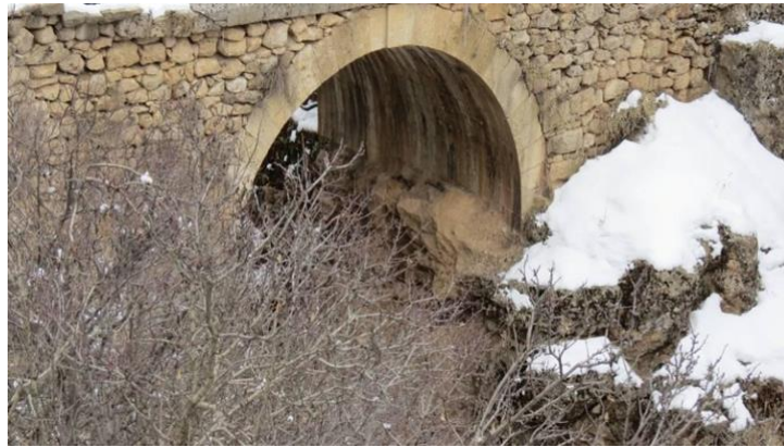
Resim 2.42: Kayakesen Köyü Köprüsü
