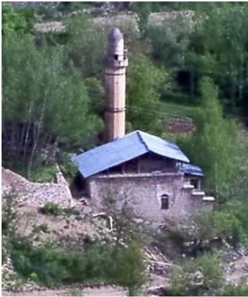
Resim 2.6: Cafer Paşa (Şeyh Hasan) Camii (Restorasyon Öncesi)
