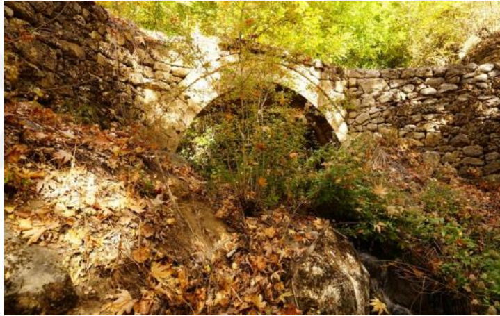
Resim 2.38: Yusuf Kamil Paşa (Küçük Köprü) Köprüsü
