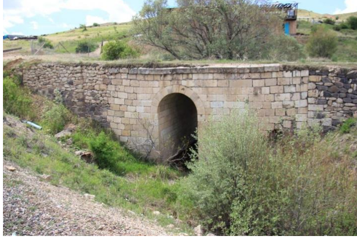
Resim 2.43: Kayakesen Köyü Köprüsü
