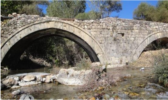
Resim 2.39. Tarhanik Köprüsü (Restorasyon Öncesi)
