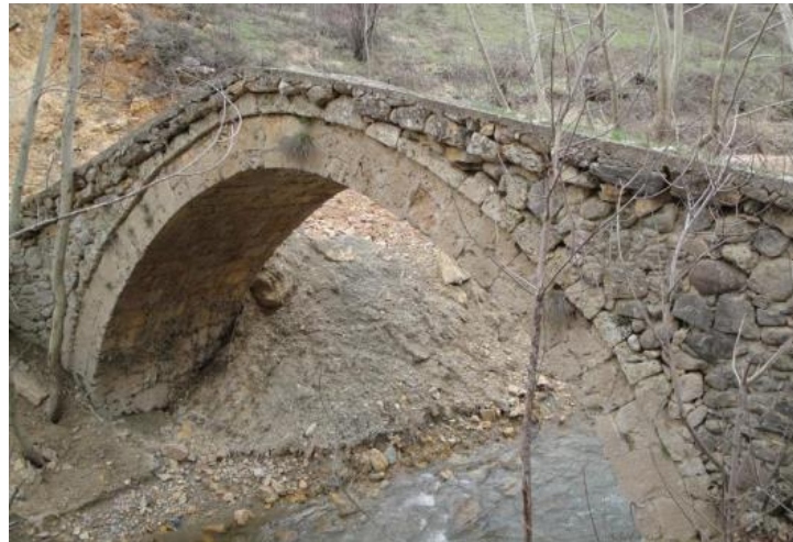
Resim 2.30: Kale Köprüsü, Restorasyon Öncesi
