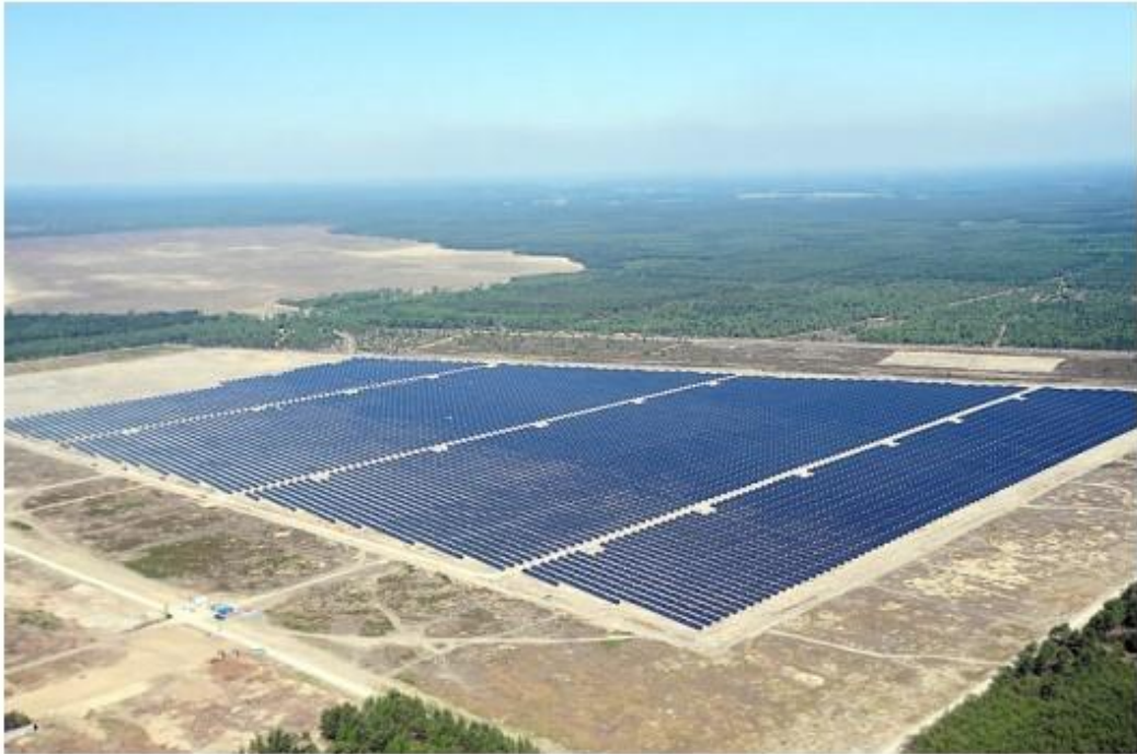
Şekil 3.1. Turnow-Preilack güneş enerjisi santrali (GİRGİN, 2011)
