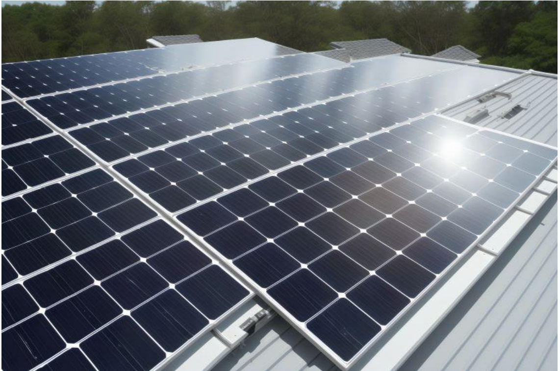
Şekil 3.7. Monokristal silikon hücrelerden yapılmış güneş paneli (Minas Enerji, tarih yok)
