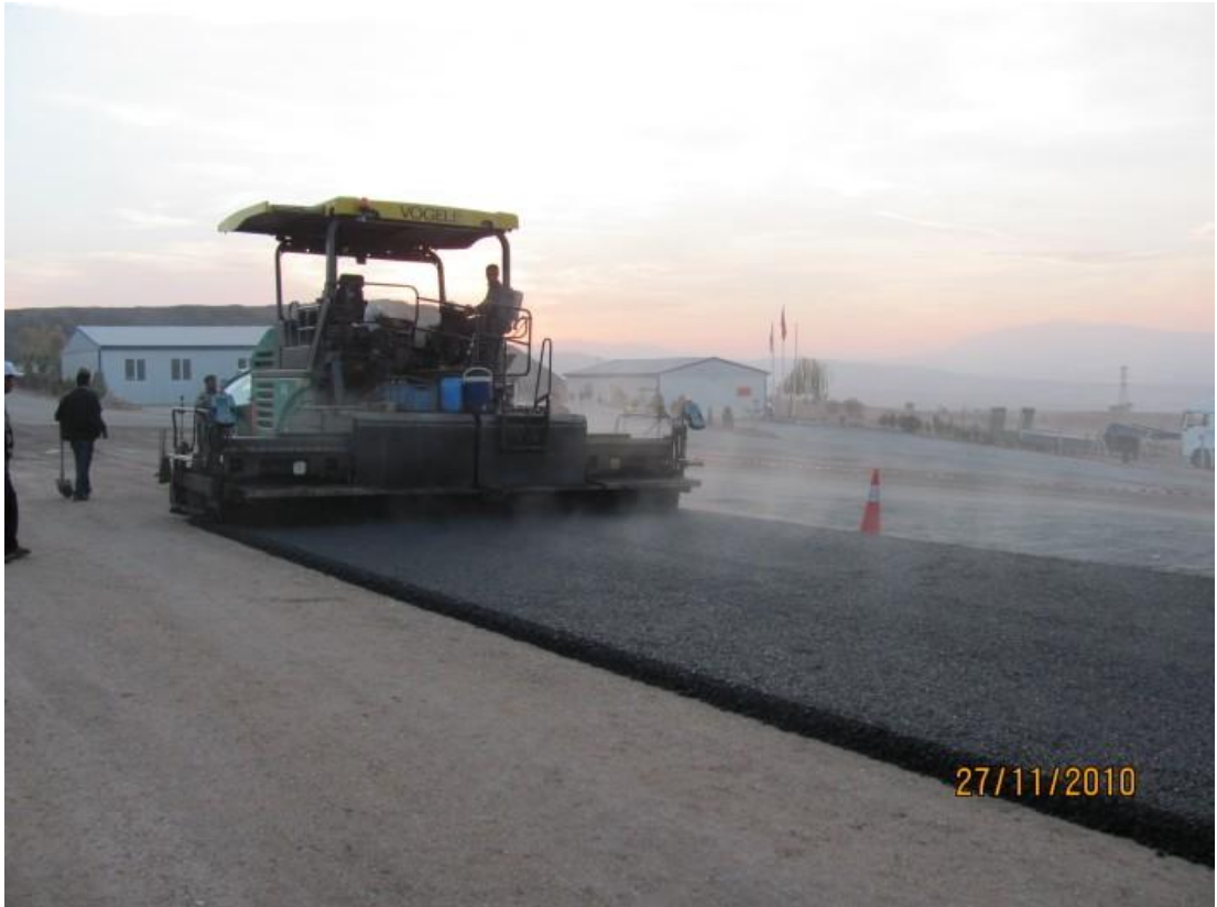
Şekil 7.8(b) Bınder tabakasının serilmesi.
