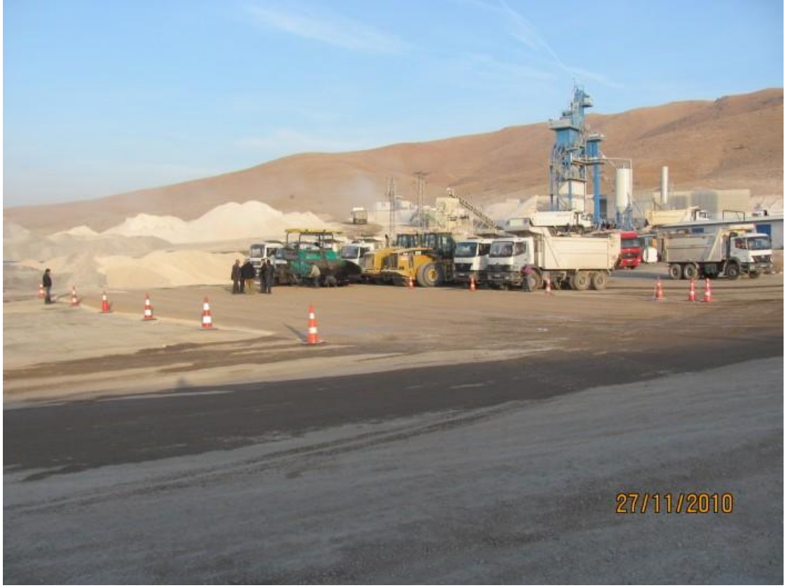
Şekil 7.8(a) Plentmix temelın serilmesi.
