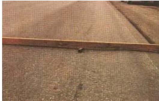
Şekil 5.10 Tekerlek izinde oturma.
