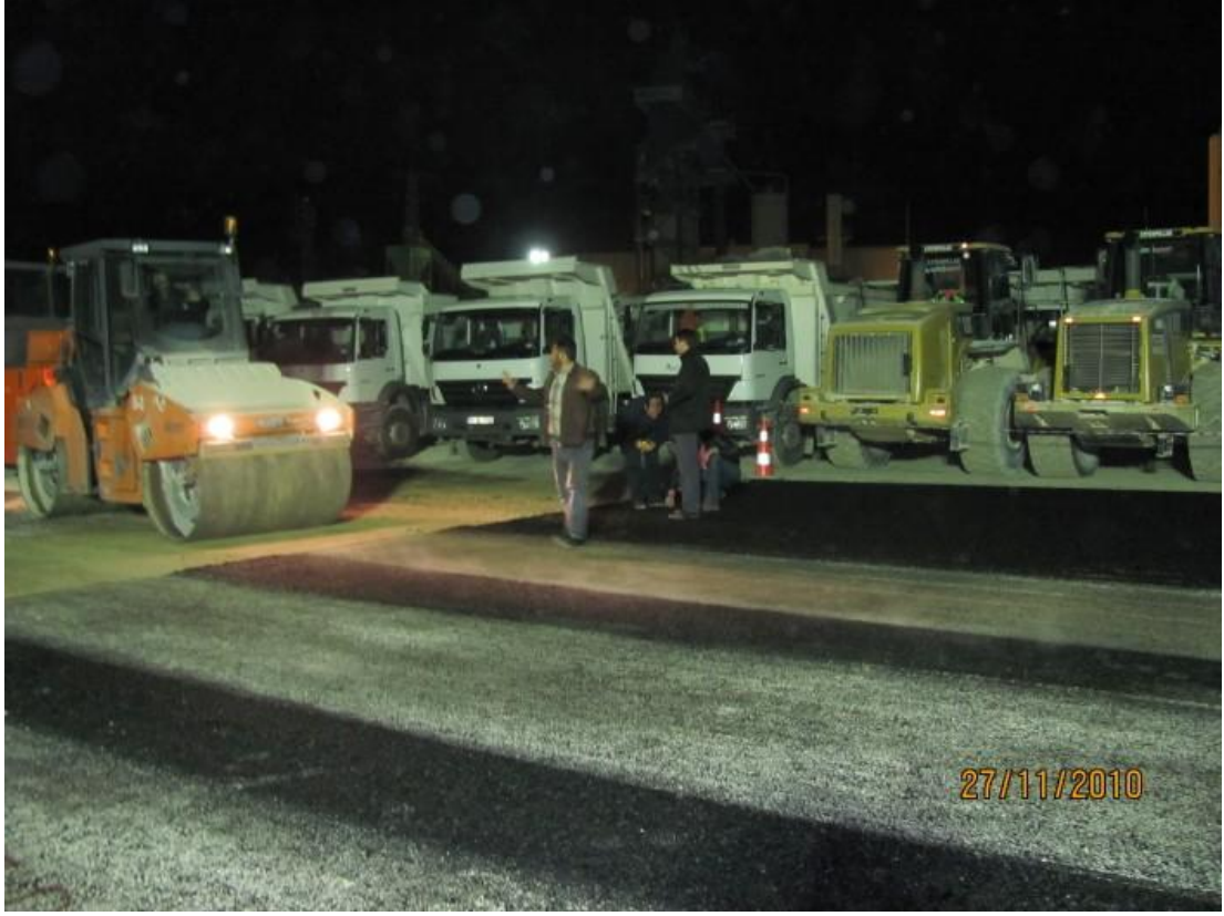
Şekil 7.8(c) Binder tabakasının sıkıştırılması.
