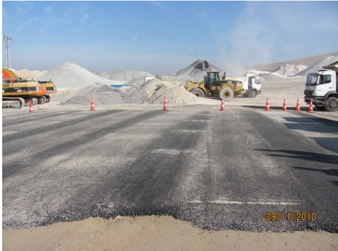
Şekil 7.8 (d) Sıkıştırılmış ve soğumuş kaplama.
