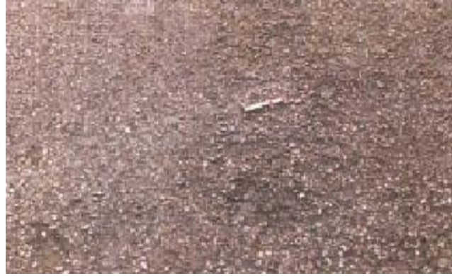
Şekil 4.3 Soyulma, sökülme tipi bozulma.
