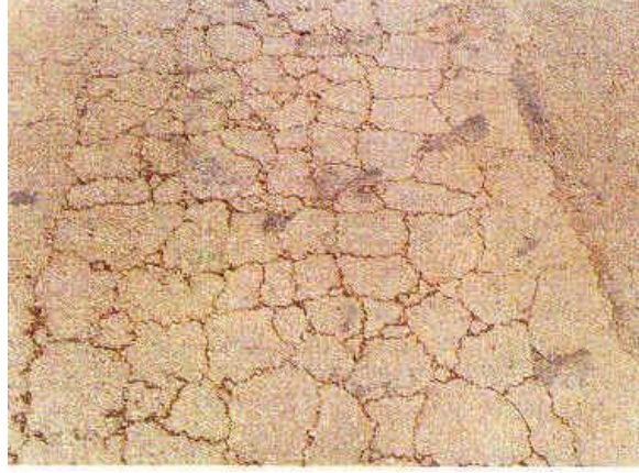
Şekil 5.11 Yorulma çatlakları.
