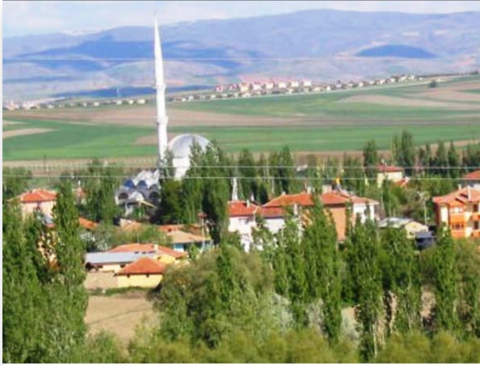
Şekil 3.27: Güldarpı Mahallesi camii.
