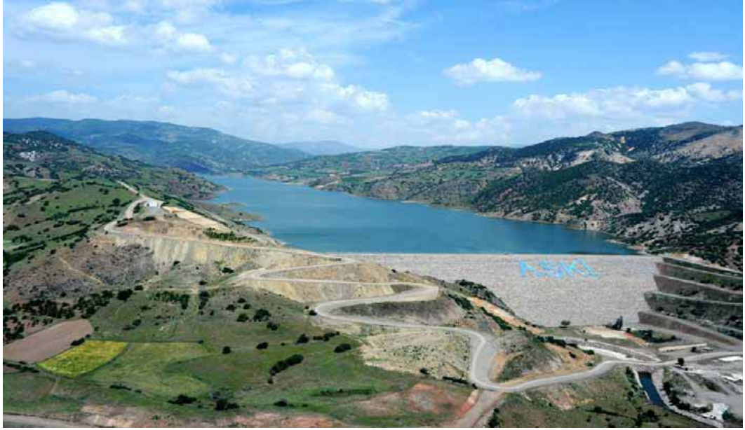
Şekil 3.30: Kavşakkaya Barajı (ASKİ, 2013).
