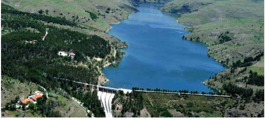
Şekil 3.29: Çubuk II Barajı (ASKİ, 2013).
