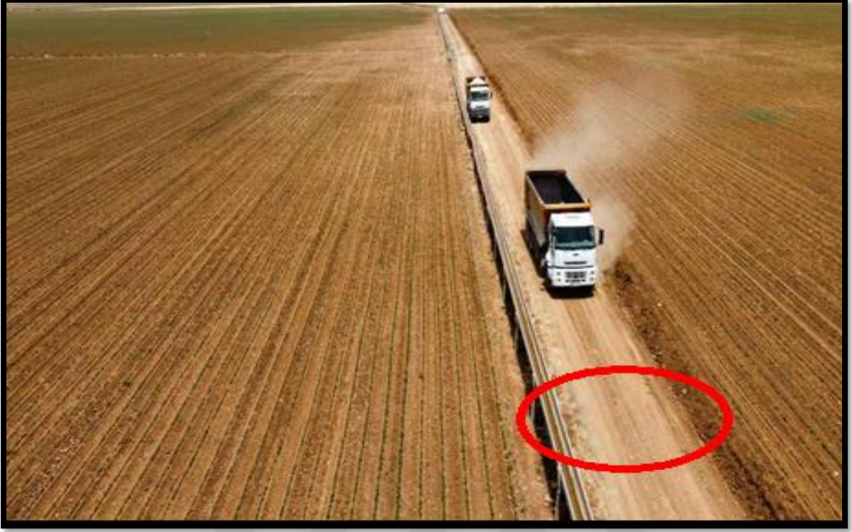
Şekil 5.9: Uygun olmayan blok yol genişliği
