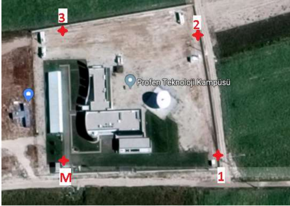
Şekil 4.6. Konya açık alan test sahası.
