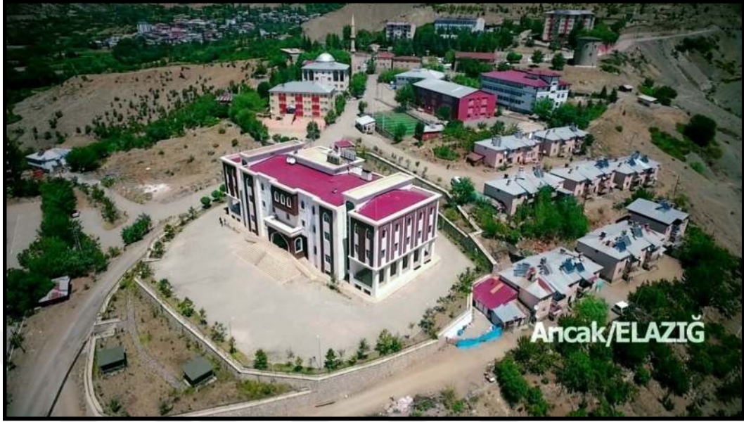
Fotoğraf 13. Kamu Kurumlarının Toplandığı Halil Yavuz Mahallesi
