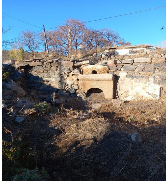
Şekil 55. Çıldır'da yıkılmış bir evin ocağı
