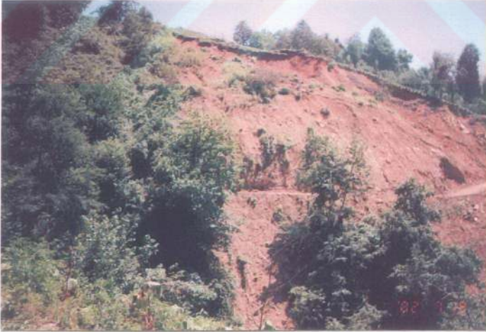
Şekil 59. Yol kazılarının neden olduğu heyelanlar
