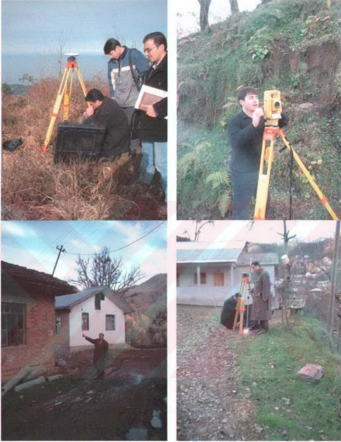
Şekil 30. Mutlak yöneltme için gerekli olan detay noktalarının arazide ölçülmesi
