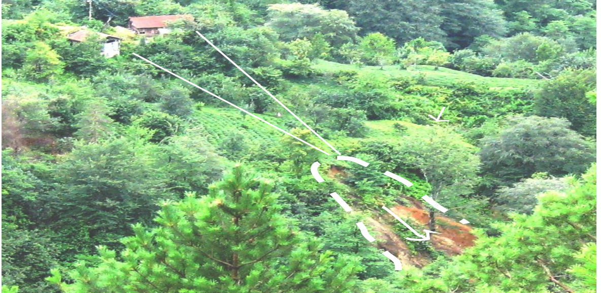
Şekil 23. Çalışma alanında tespit edilen heyelan alanı
