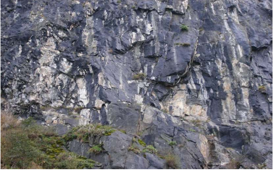
Şekil 12. Çağlayan Formasyonundaki bazaltlarda oluşan çatlaklar
