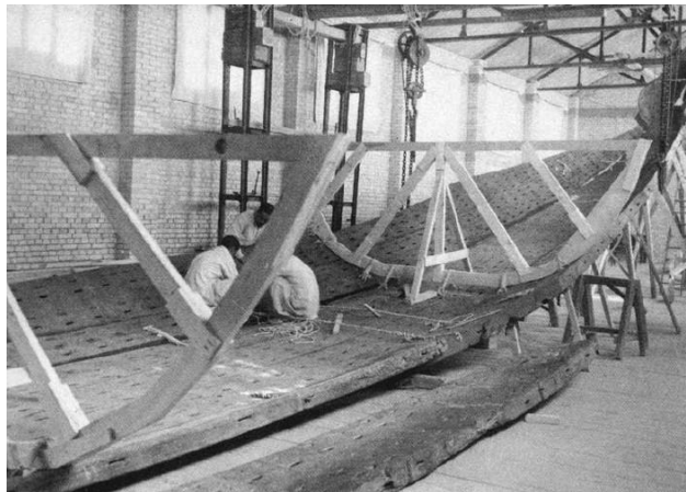
Şekil 2. 127: Gemi monte edilirken kullanılan ahşap kalıplar.
