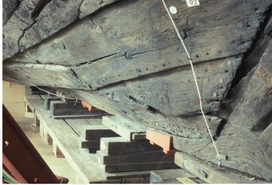
Şekil 2. 30: Batığın ağırlık kaynaklı deformasyona uğramış hali.
