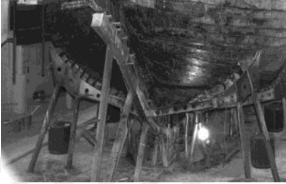
Şekil 2. 21: Batık pontona ilk yerleştirildiğinde yapılan destekleyici payandalar.
