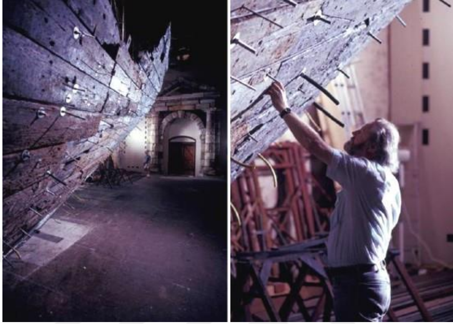
Şekil 2. 119: Ahşap elemanları birleştiren saplamaların montajı
