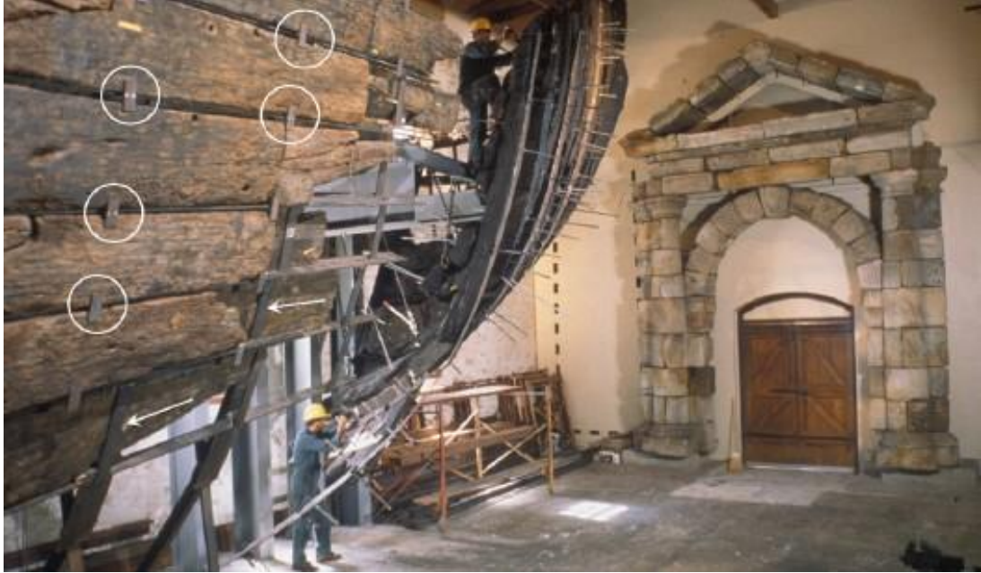
Şekil 2. 118: Gövdeyi taşıyan dikey metal şerit ve tapalar.
