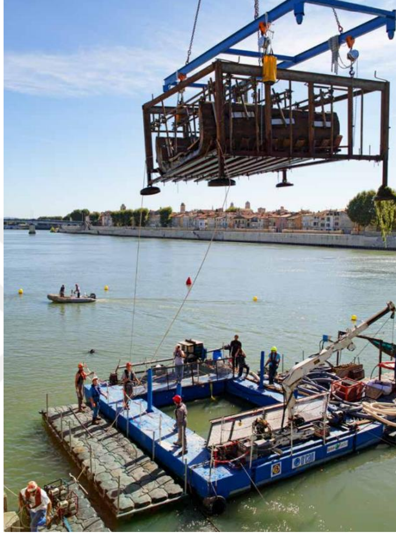
Şekil 2. 70: Batığın üçer metrelik aralıklarla bölünerek kaldırılması.
