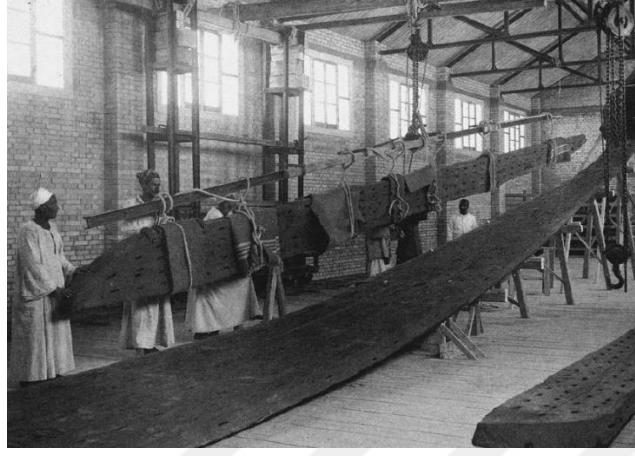
Şekil 2. 126: Gemi monte edilirken çelik kirişlere bağlanarak kaldırılan kaplama.
