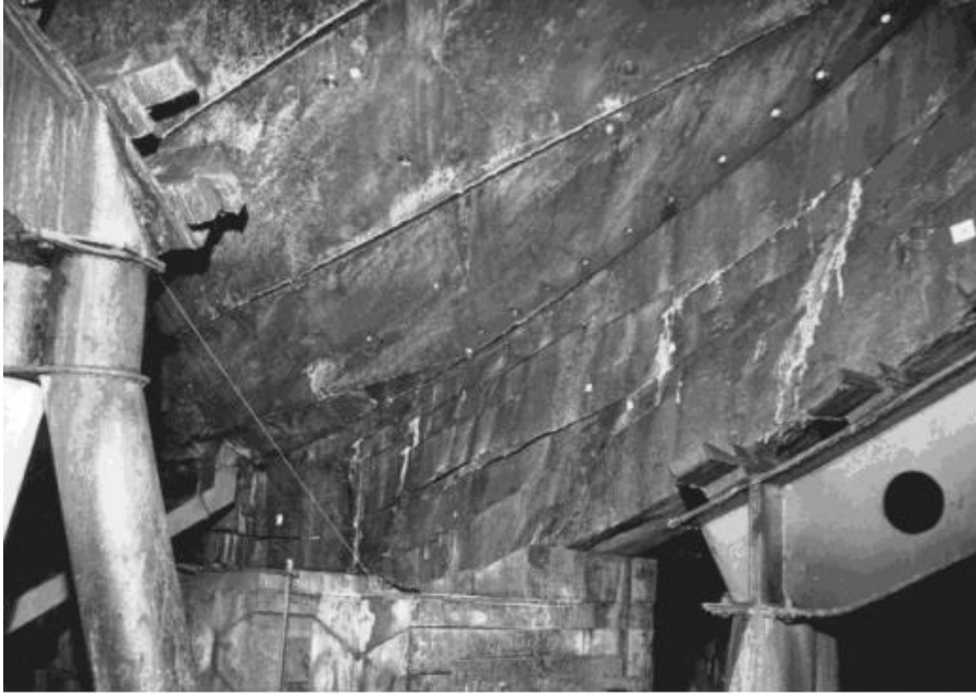
Şekil 2. 22: Batık pontona ilk yerleştirildiğinde yapılan destekleyici payandalar.
