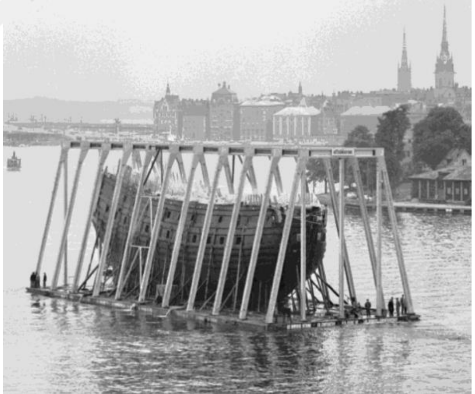
Şekil 2. 12: Batık gövdesinin yüzer şamandıra vasıtasıyla ponton üstüne taşınması.
