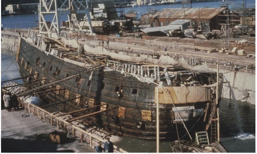
Şekil 2. 13: Batığın ponton üstüne yerleştirilmesi.
