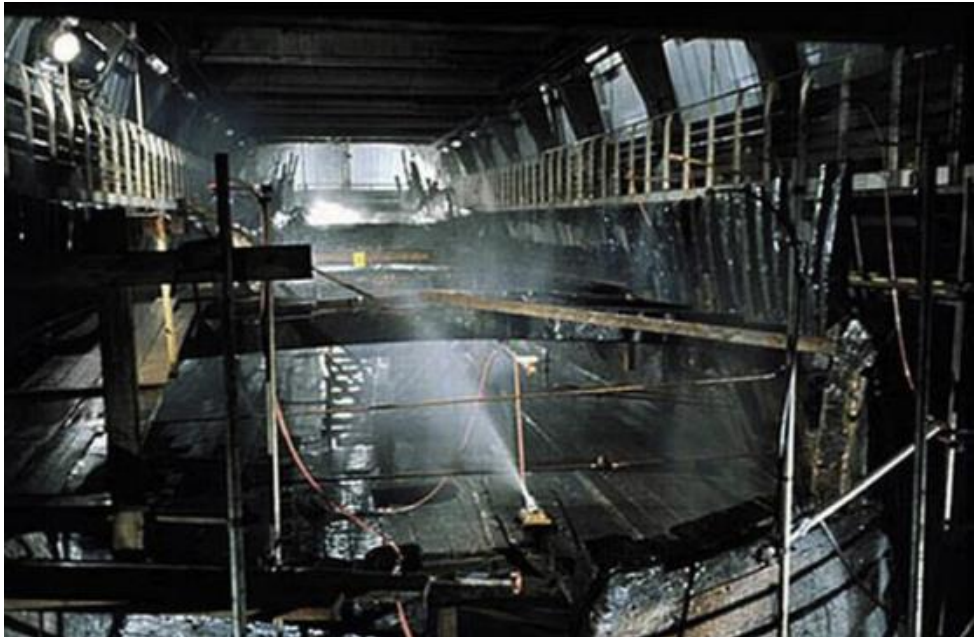
Şekil 2. 15: Sprey yöntemiyle PEG uygulaması.
