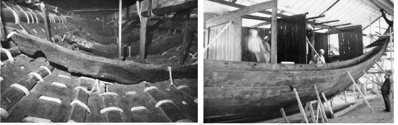
Şekil 2. 128: Geminin iç görünümü ve kabinin montajı.
