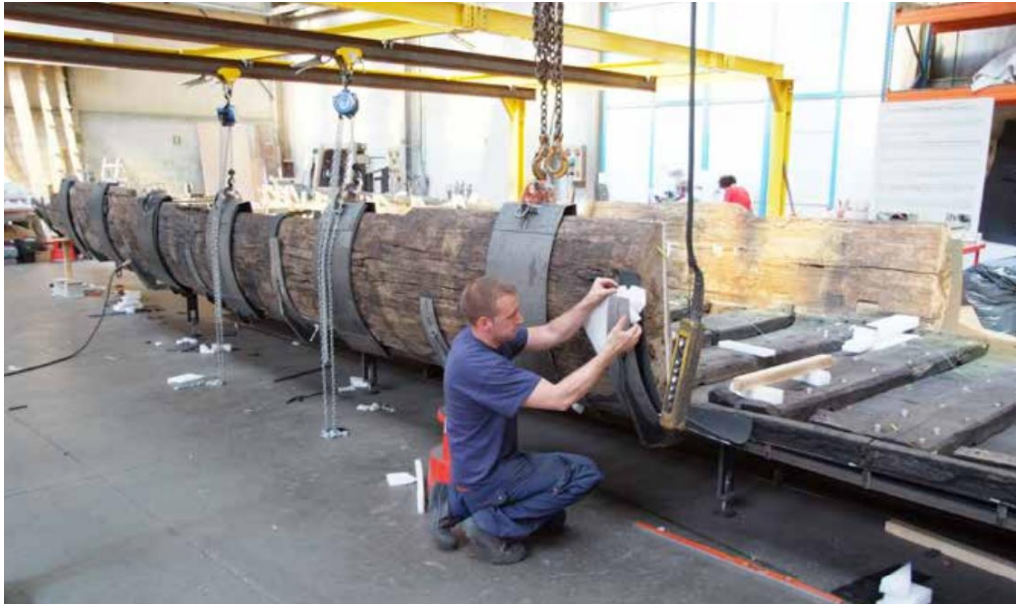
Şekil 2. 77: G vde ahşaplarının taşıyıcı konstr ksiyon  zerinde yeniden montaj  alıřmaları.
