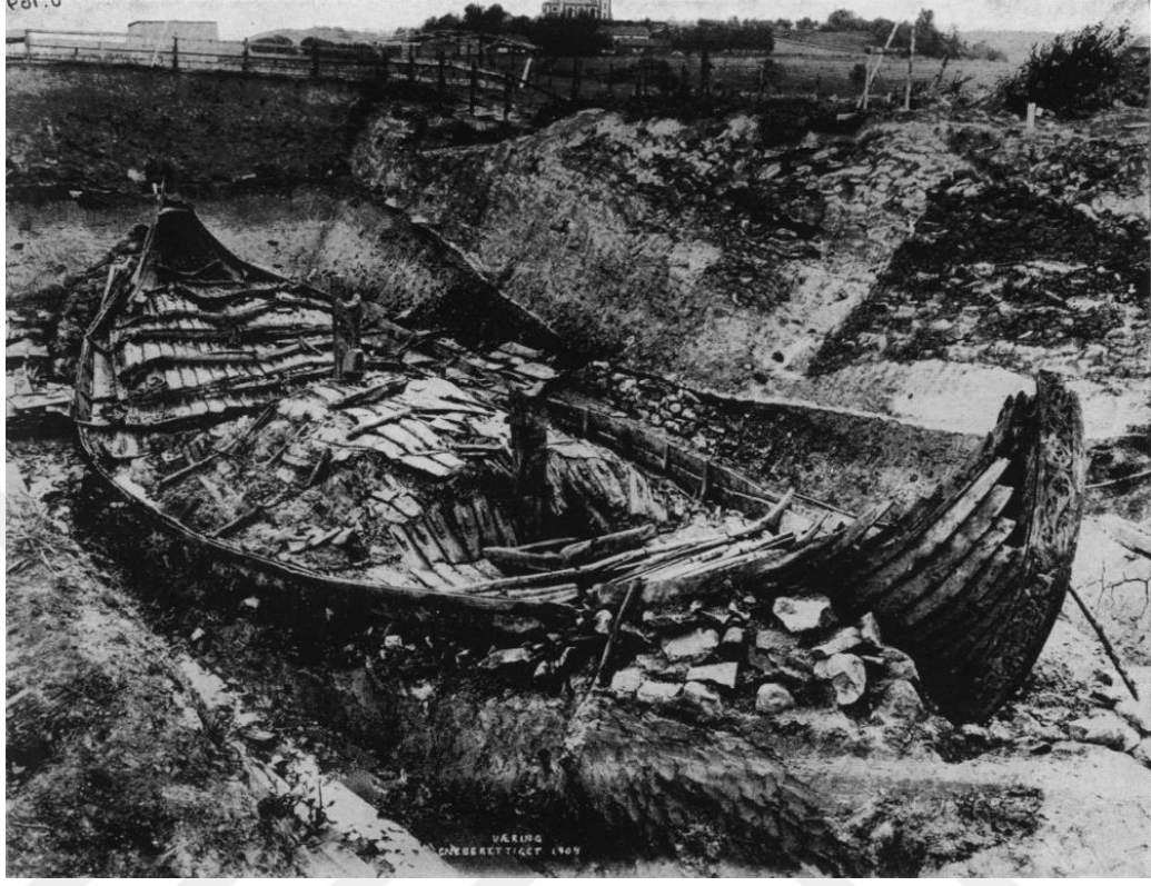
Şekil 2. 62: Höyük içerisindeki basıncın etkisiyle ahşapların deforme olması.
