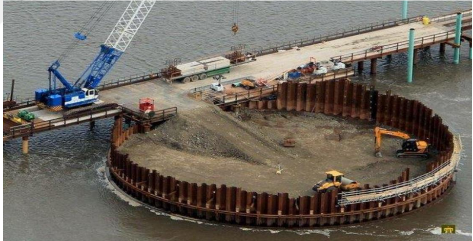
řekil 2. 90: Batık alanına batardo yapılması.
