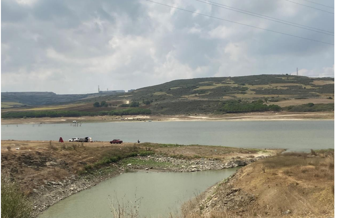
Fotoğraf 2: Sazlıbosna Barajı
