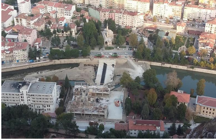
Şekil 4.2. Arşimet burğu türbin ve lastik set inşaatı (Amasya)
