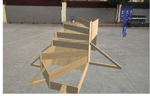
b) Montaj bölümü betonsuz görünüm
