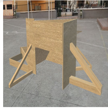
t) Bitmiş kalıp cephe
