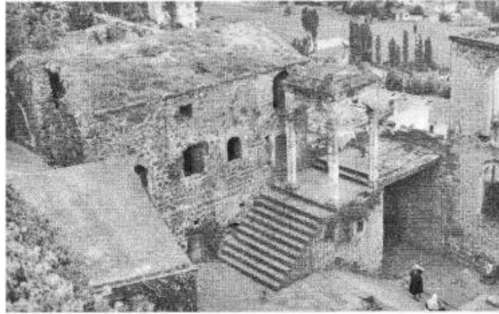
Şekil 32. Güneydoğudan manastır avlusu ve Çan Kulesi (Bryer & Winfield, 1970)
