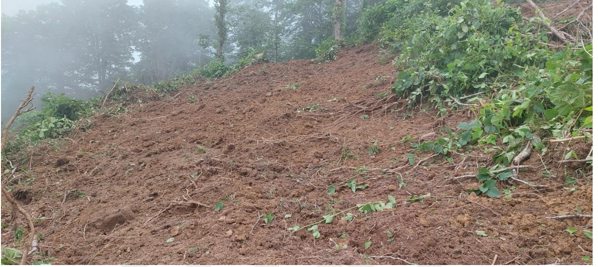
Şekil 4.3 Çalışma alanında mekanik ekipman kullanılarak gerçekleştirilen arazi hazırlığı uygulamalarından bir görünüm
