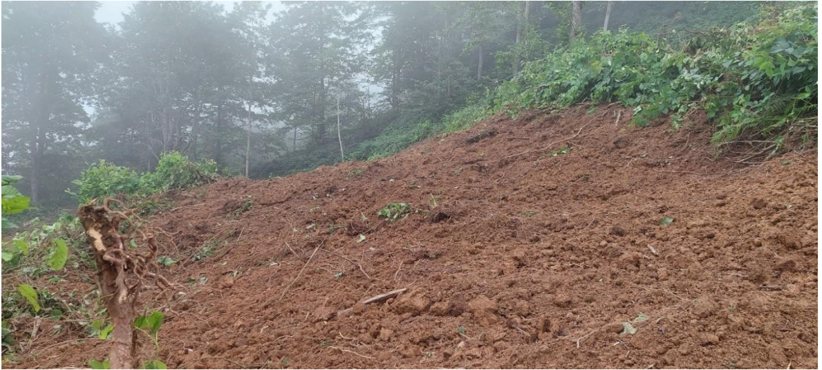
Şekil 4.4 Makineli arazi hazırlığı sonrasında üst toprak tabakasının sıyrıldığı alanlara ait görünüm
