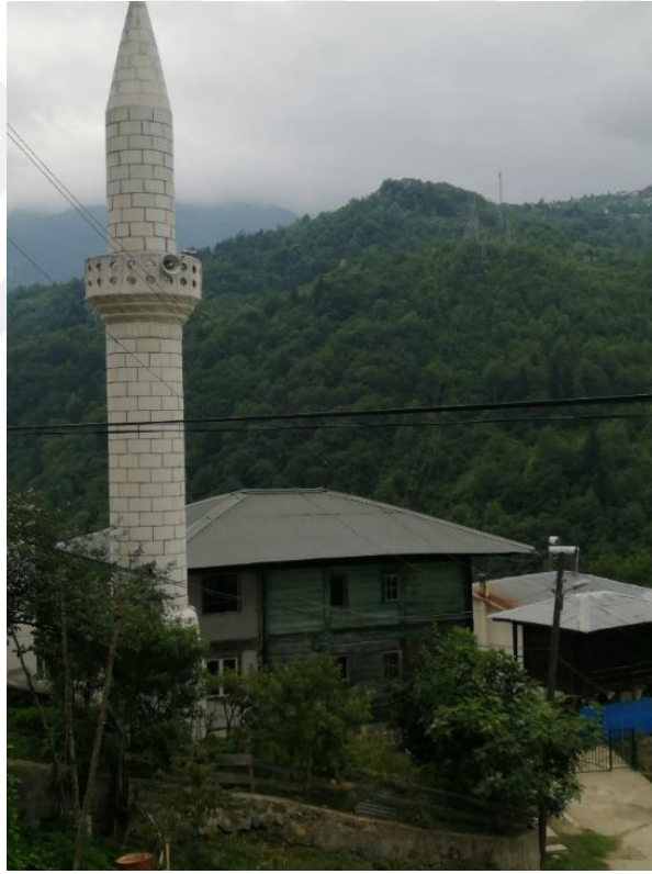
Fotoğraf 79. Erenköy Köyü Merkez Camii dıştan görünüm ( B. ACAR ALTUNTAŞ, 2022)
