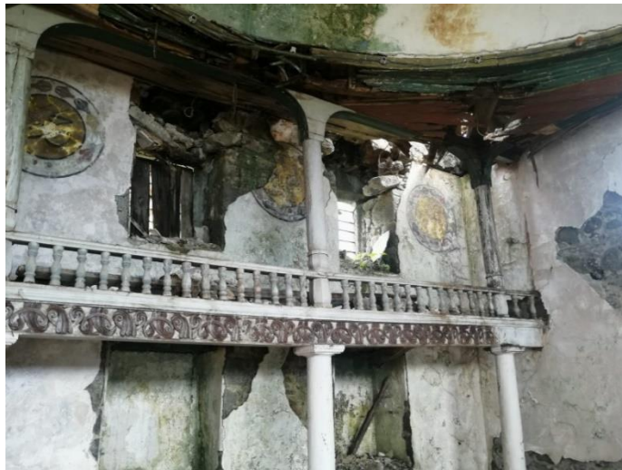
Fotoğraf 56. Esenkıy Köyü Camii mahfil korkulukları ( B. ACAR ALTUNTAŞ, 2023)
