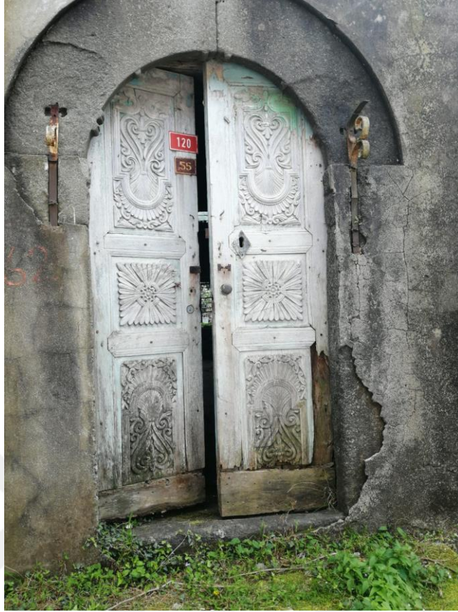
Fotoğraf 54. Esenkıyı Köyü Camii kapısı ( B. ACAR ALTUNTAŞ)
