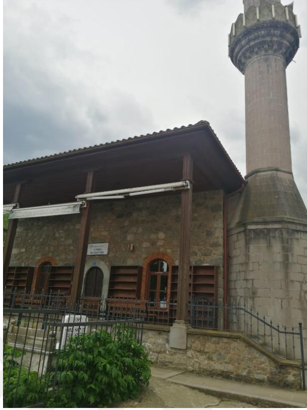
Fotoğraf 57. Sundura Mahallesi Camii dıştan görünüm ( B. ACAR ALTUNTAŞ, 2023)
