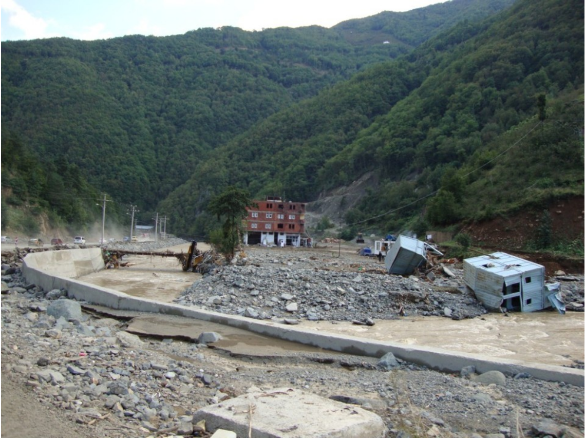
Şekil 38. Dere Yatakları İçinde/Yakınında Yapılan Hatalı Yapılaşma ve Ulaşım Yolu (Borçka, Artvin)
