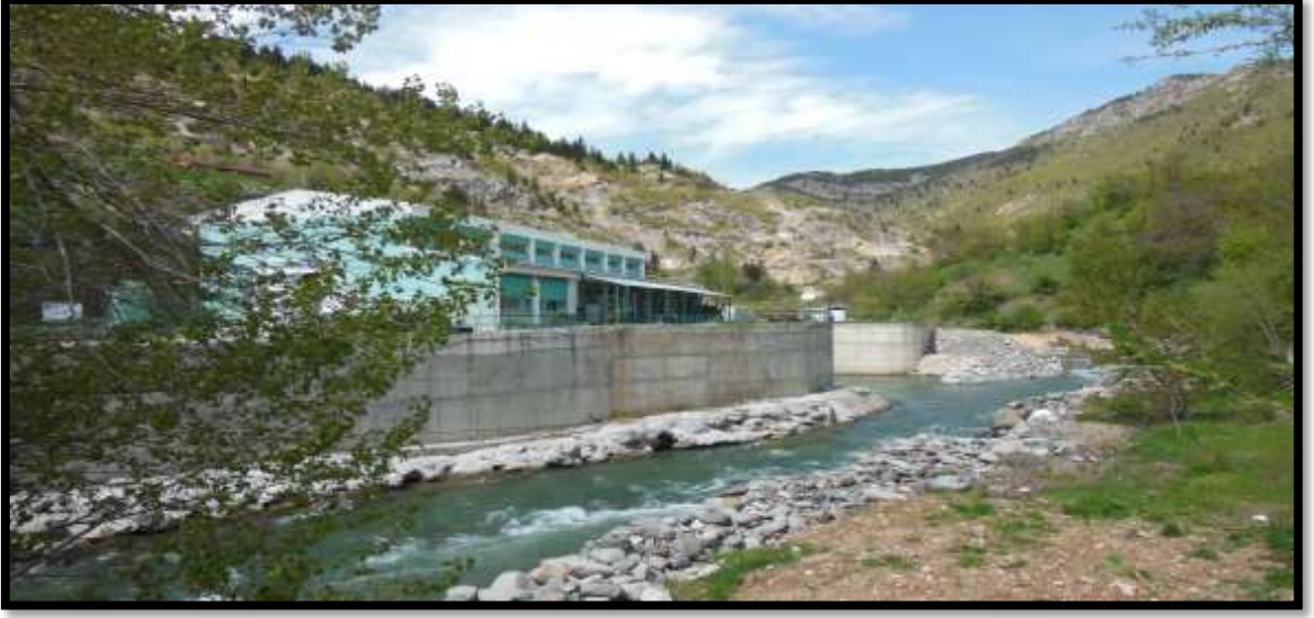
Şekil 13. Papart HES binası (24.04.2016)
