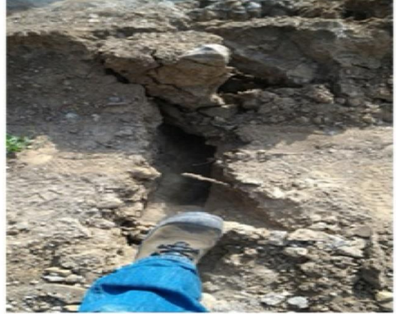
c- Çatlak yakın görüntü
