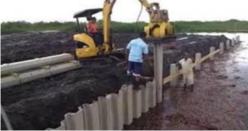
Şekil 1.10. Palplanş perdesinin ortaya çıkarılması (URL-2, 2021)
