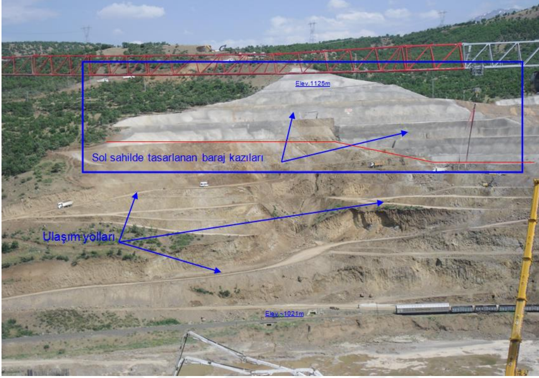
Resim 3.1. Sol sahil baraj kazıları
