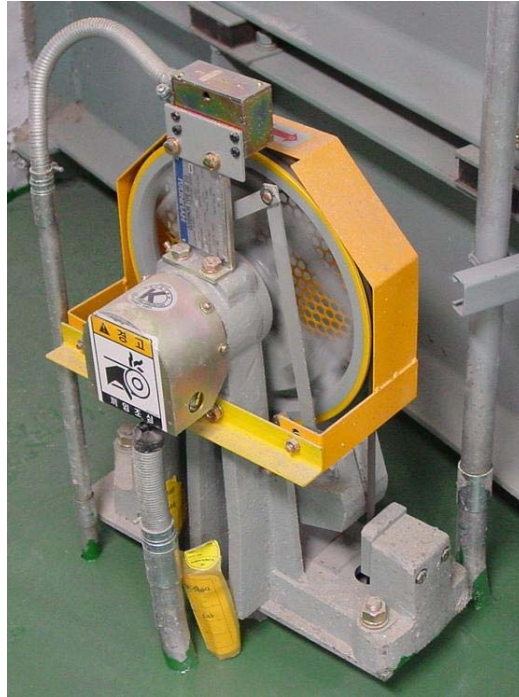
Şekil 2.5 : Aşırı hız regülatörü.
