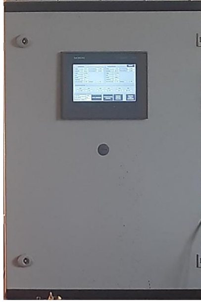
Şekil 3.14. Motor kontrol panosunun dış tasarımı
