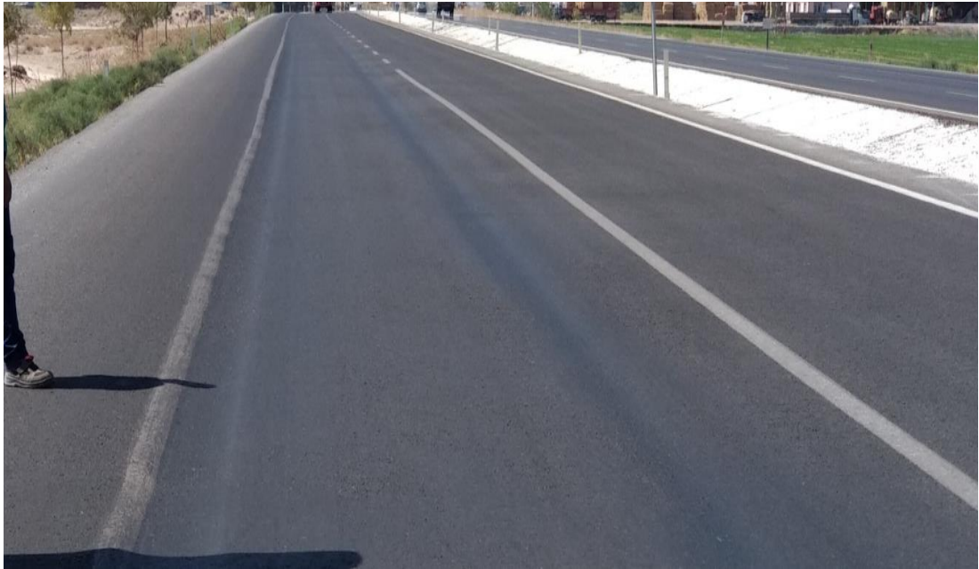
Şekil 1.30. Zayıf karışımdan kaynaklanan tekerlek izinde oturma.
