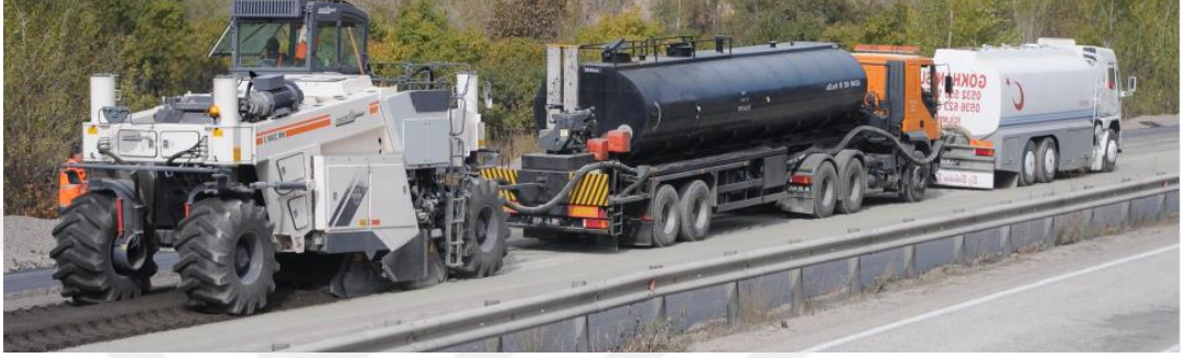
Şekil 2.14. Yerinde soğuk geri dönüşüm uygulaması (Orhan, 2012a).
