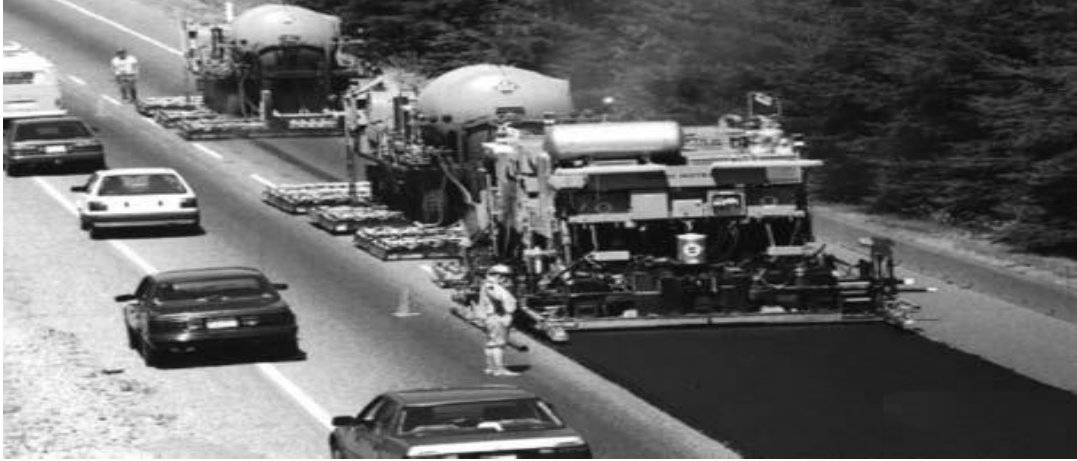
Şekil 2.10. Tek aşamalı karıştırma treni (ARRA, 2001).
