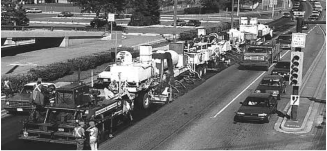
Şekil 2.9. Yerinde sıcak geri dönüşüm karıştırma treni (ARRA, 2001).
