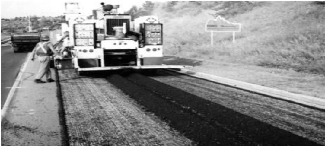
Şekil 2.11. Çok aşamalı karıştırma treni ile kazılan kaplama (ARRA, 2001).
