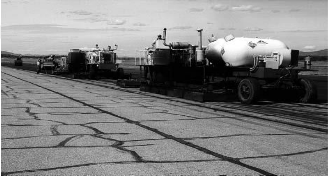
Şekil 2.6. Yüzeysel geri dönüşüm ısıtma üniteleri (ARRA, 2001).
