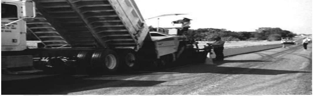
Şekil 2.16. CCPR Karışımının serilmesi (ARRA, 2001).
