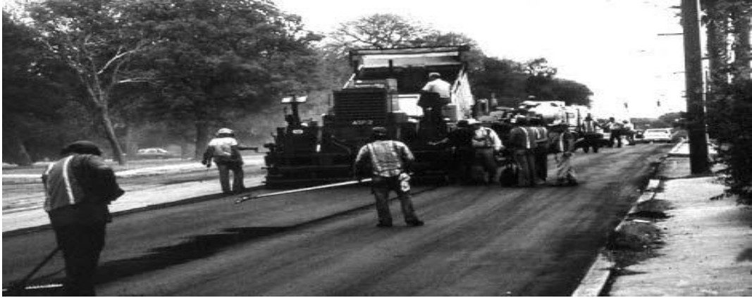
Şekil 2.12. Çok geçişli yeniden yapım uygulaması (ARRA, 2001).
