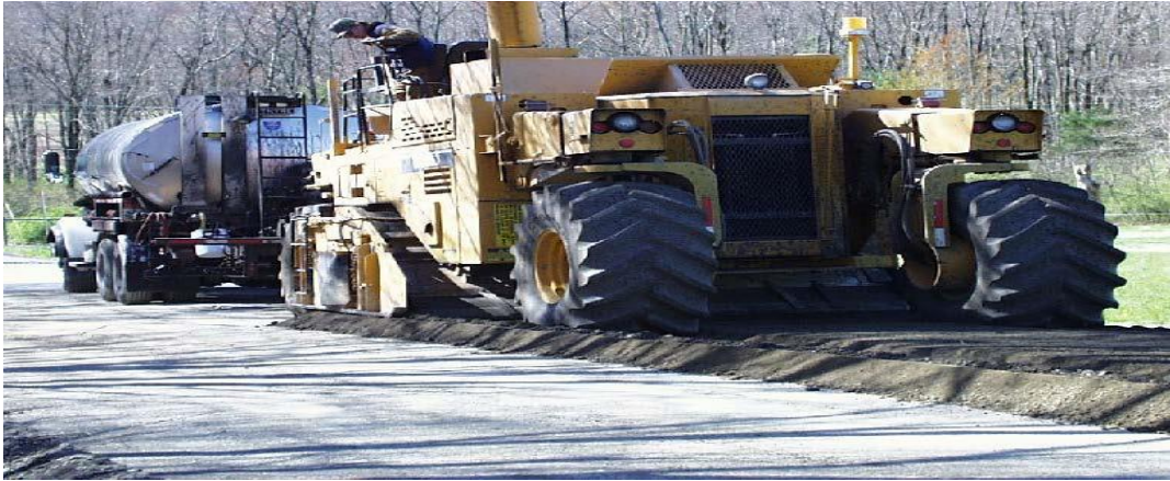
Şekil 2.17. Tam derinlikli geri dönüşüm uygulaması.
