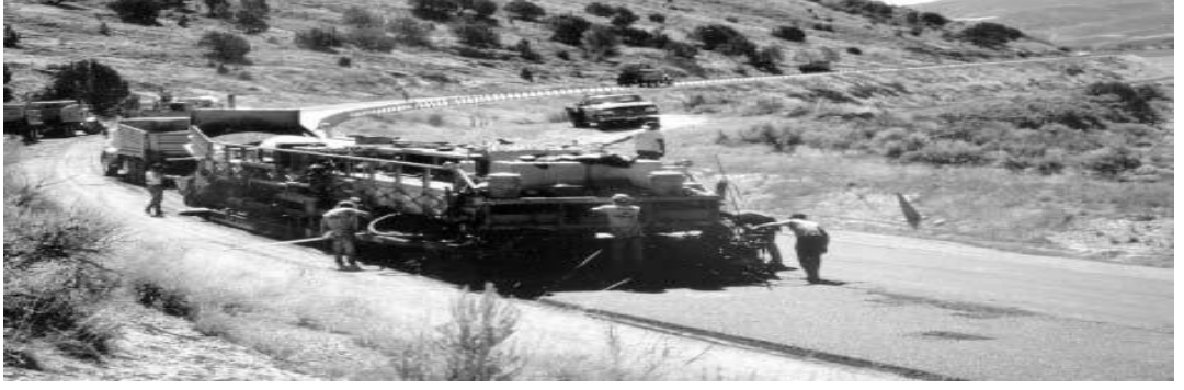
Şekil 2.13. Tek geçişli yeniden yapım uygulaması (ARRA, 2001).
