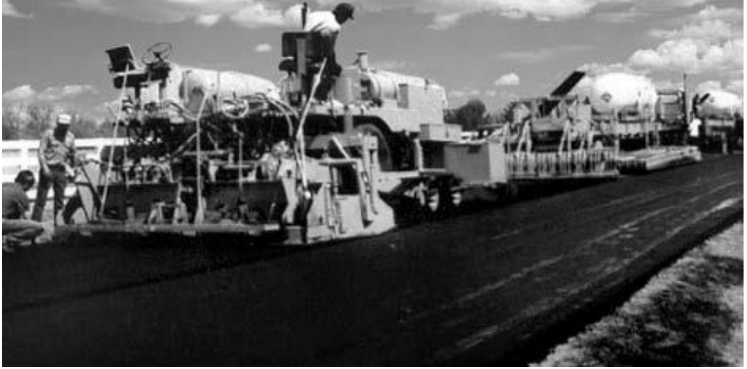
Şekil 2.8. Geri dönüşüm karışımın serilmesi (ARRA, 2001).
