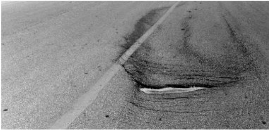
Şekil 12. Yol yüzeyindeki kayma çatlaması (Karakaş, 2014)
