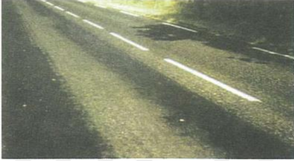
Şekil 16. Asfalt yüzeyindeki kusma problemi (Ilıcalı vd., 2001)
