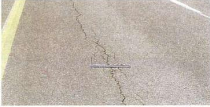
Şekil 11. Derz çatlağı (Ilıcalı vd., 2001)
