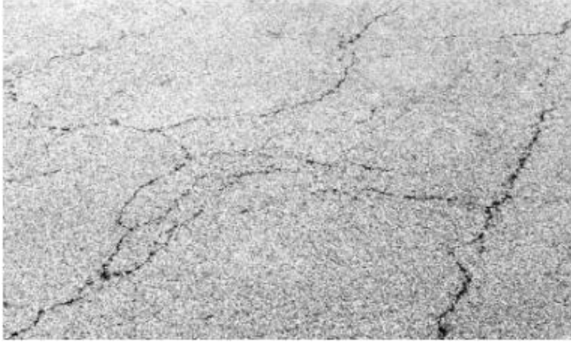
Şekil 9. Stabilite çatlağı (Karakaş, 2014)
