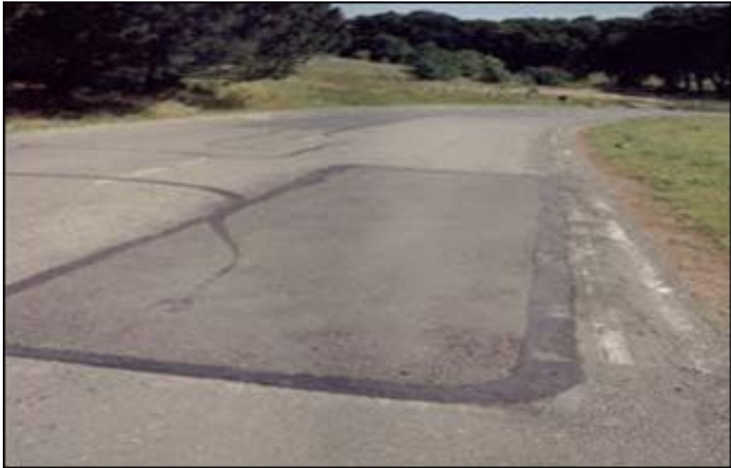
Şekil 22. Hazırlanan Çukurun Doldurulması ve Kenarların Mühürlenmesi (State of California Department, 2007).
