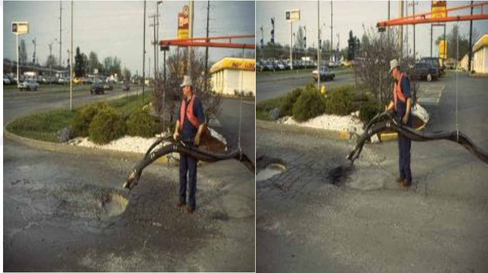
Şekil 21. Alan Hazırlığı ve Yapışkan Tabaka Uygulanması
