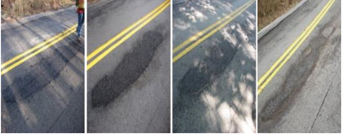
Şekil 15. At Sıkıştır Yama Örneğinin Zamanla Bozulma Performansı (Dong, Huang, & Jia, 2014).
