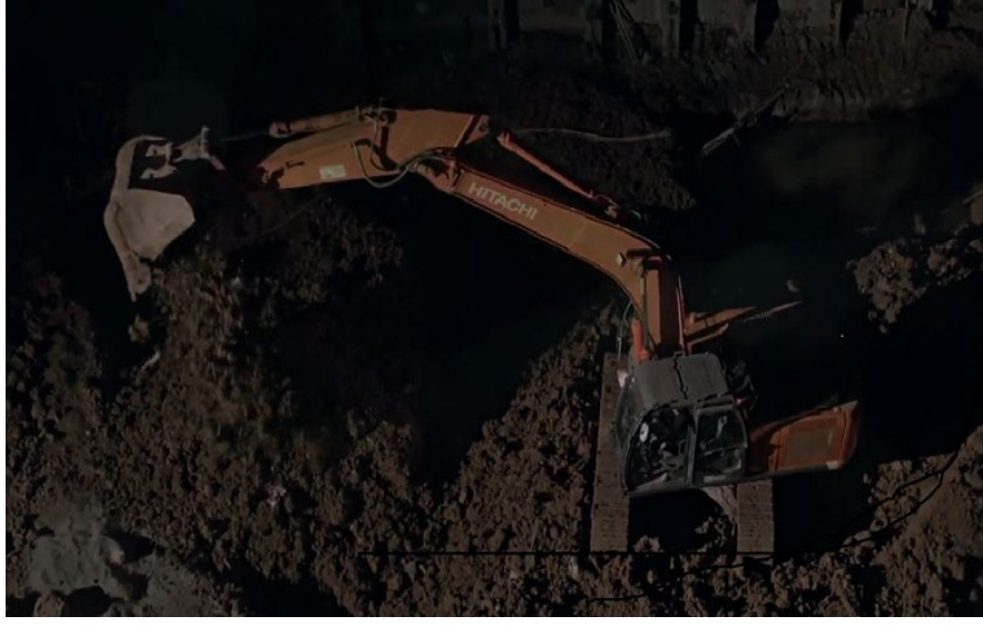
Görsel 4.51. Apartmanın Yanında Çalışma Yapan İş Makinesi
