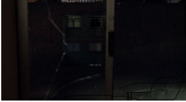
Görsel 4.52. Pencere Camlarının Çatlaması
